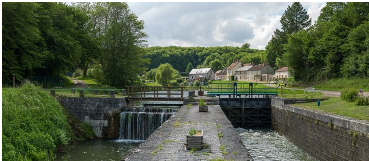
Vue de l'écluse avec le déversoir à gauche, l'ensemble pris d'aval.
