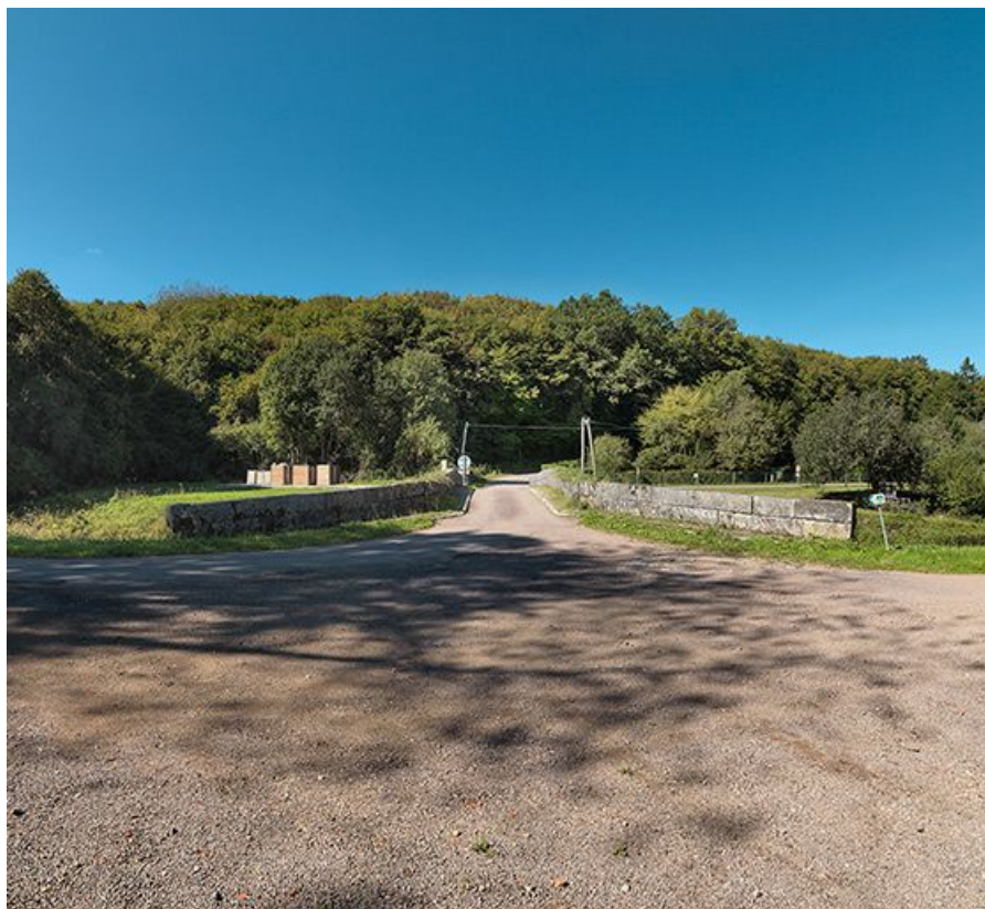
Vue d'ensemble du pont, avec les parapets.
