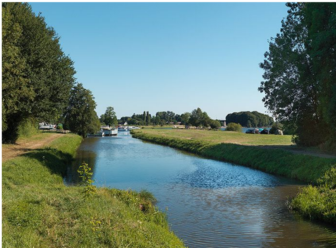
Vue de la rigole avec en arrière-plan, le port des Poujats.
