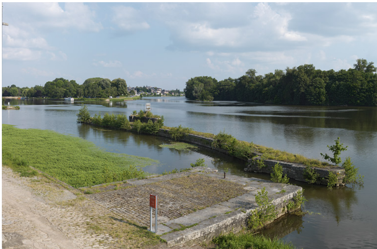
Le quai et le pertuis en maçonnerie de moellon devant le maison. En arrière-plan, la ville de Decize. 58, Decize, lieudit : bief 35 du versant Loire
