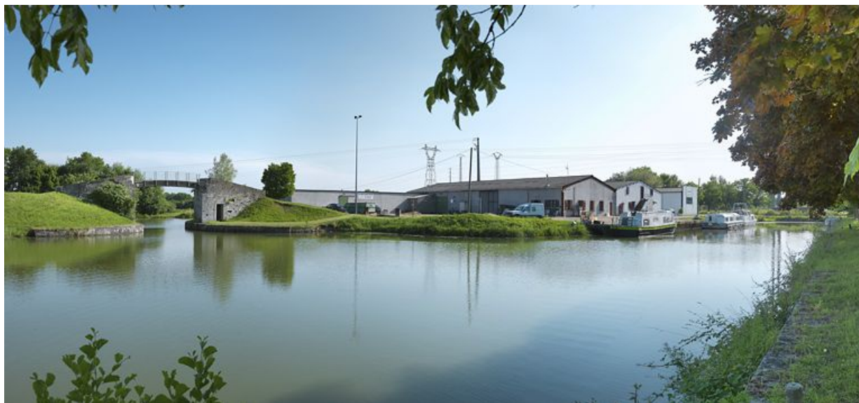
Vue d'ensemble du port. A gauche, la passerelle.
