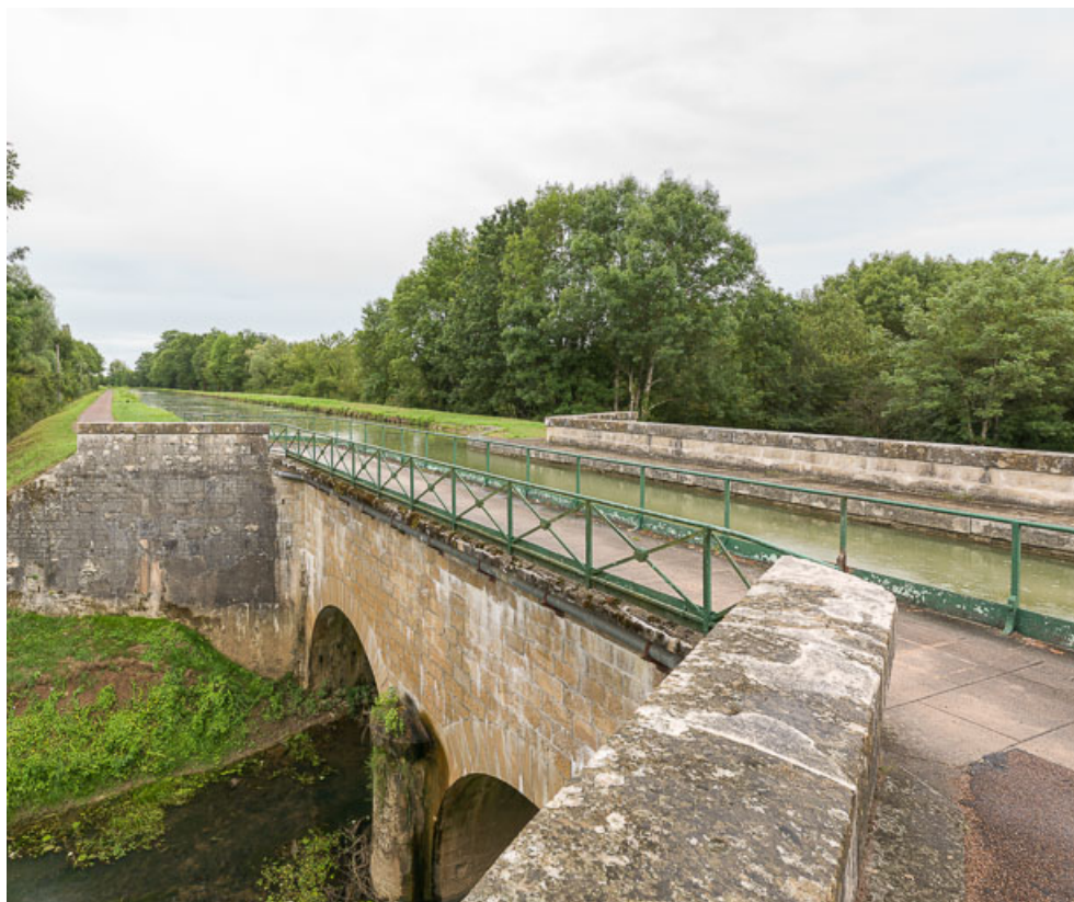
Détail du tablier rive droite et du garde-corps en métal.
