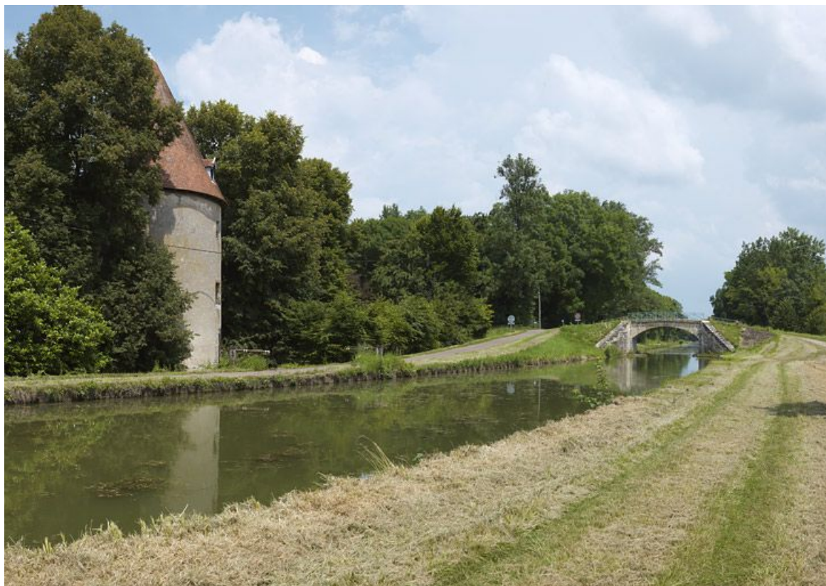
Le pont vu d'aval. A gauche : une tour du château.
