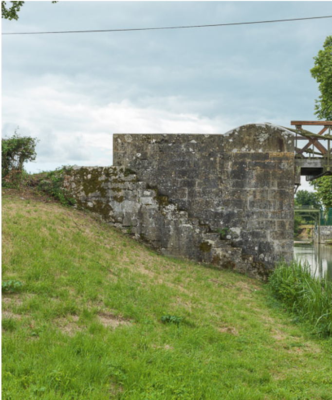
Détail d'une culée en moellons.
