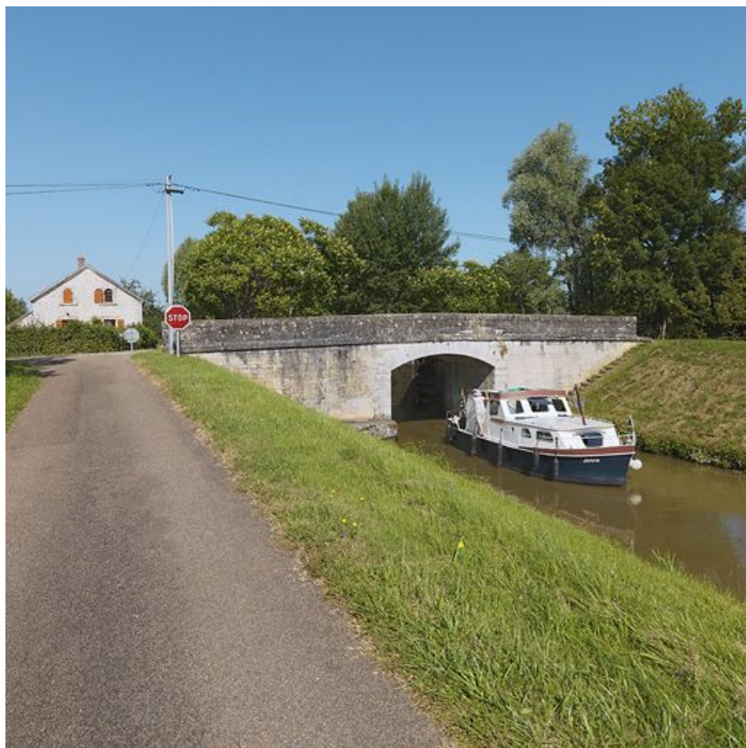
Le pont, vue d'aval. On distingue à gauche la maison éclusière du site 22 L. 58, Biches, lieudit : bief 22 du versant Loire
