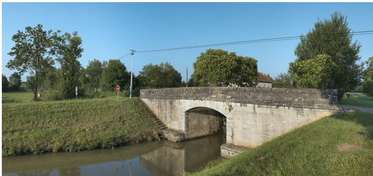
Vue d'aval du pont.
