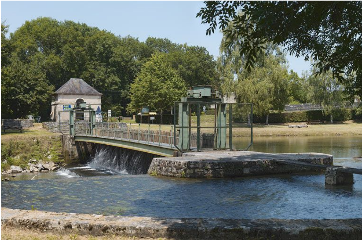
Vue d'ensemble du barrage. Au premier plan, le déversoir et au fond, la maison du barragiste. 58, Biches, lieudit : bief 22 du versant Loire
