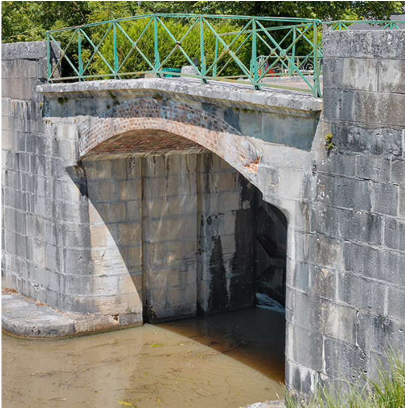
Vue rapprochée de la voûte en brique.
