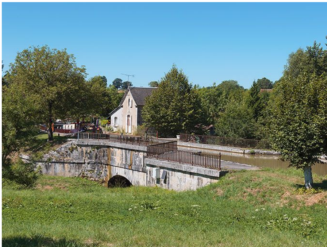
Le pont canal de Mingot. En arrière-plan, la maison éclusière du site de l'écluse 13 du versant Loire. 58, Châtillon-en-Bazois, lieudit : bief 13 du versant Loire
