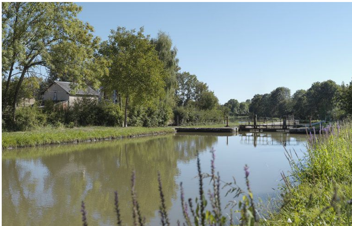
Le site d'écluse, d'amont. La maison éclusière à gauche.
