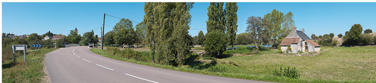
De gauche à droite : le village de Bazolles, le pont sur écluse, le canal et la maison éclusière avec ses annexes. 58, Bazolles, lieudit : bief 03 du versant Loire
