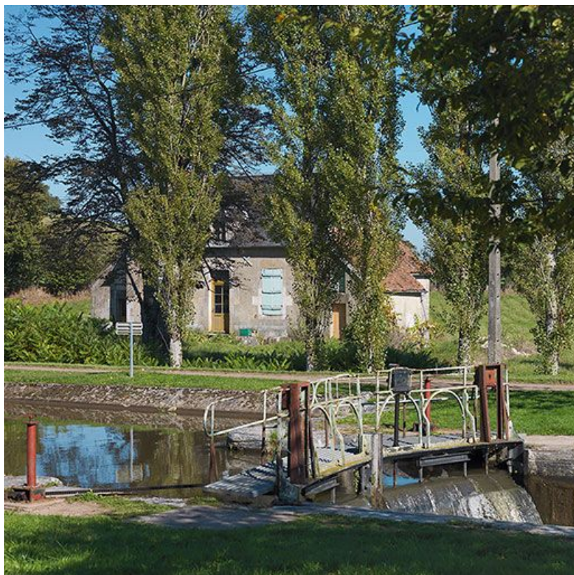
La maison éclusière depuis la rive droite du canal.
