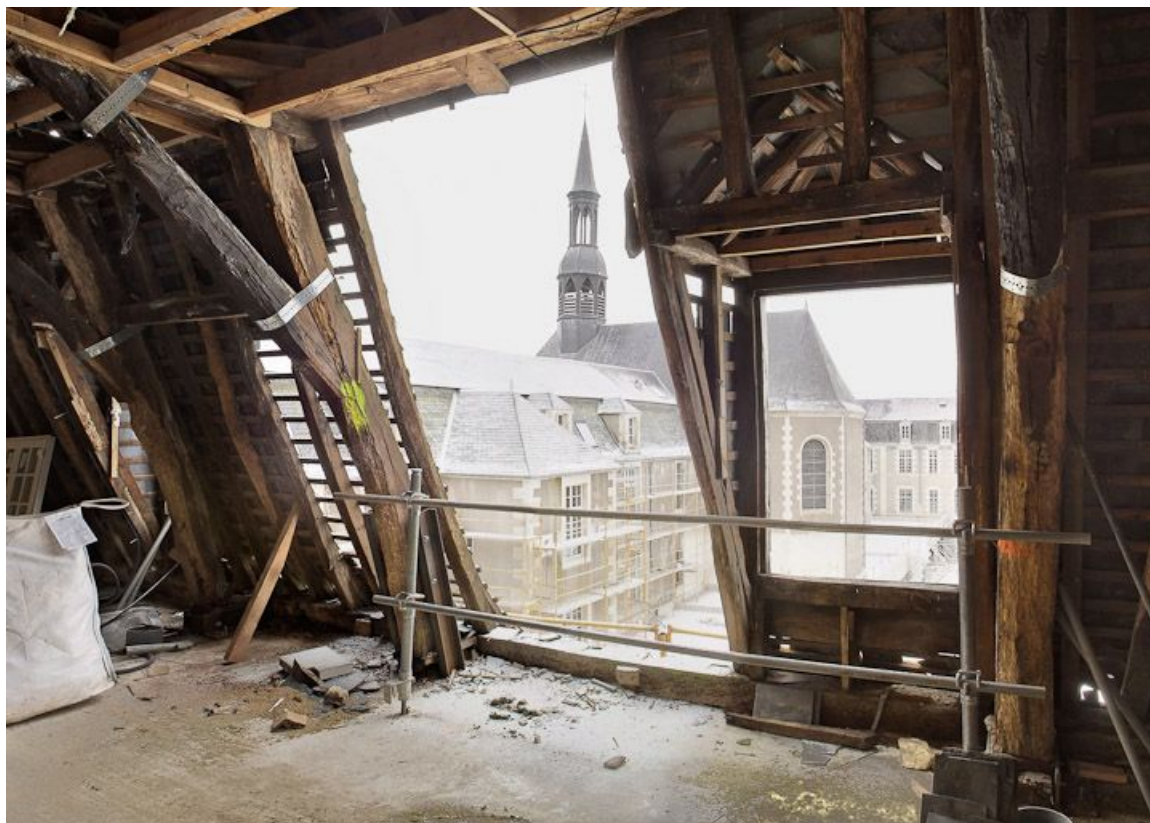
Les combles de l'aile Sud de l'ancien hôpital général : vue sur la chapelle. 58, Nevers Colbert
