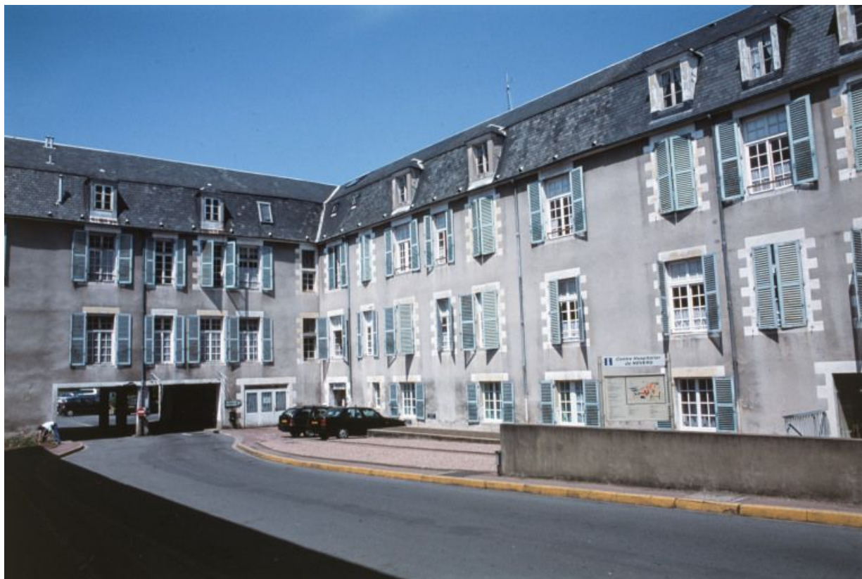
Façade postérieure, partie gauche. 58, Nevers Colbert
