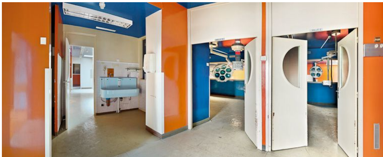
Bâtiment Maternité-Gynécologie (Gérontologie au moment de la prise de vue) : ancienne salle d'accouchement. 58, Nevers Colbert
