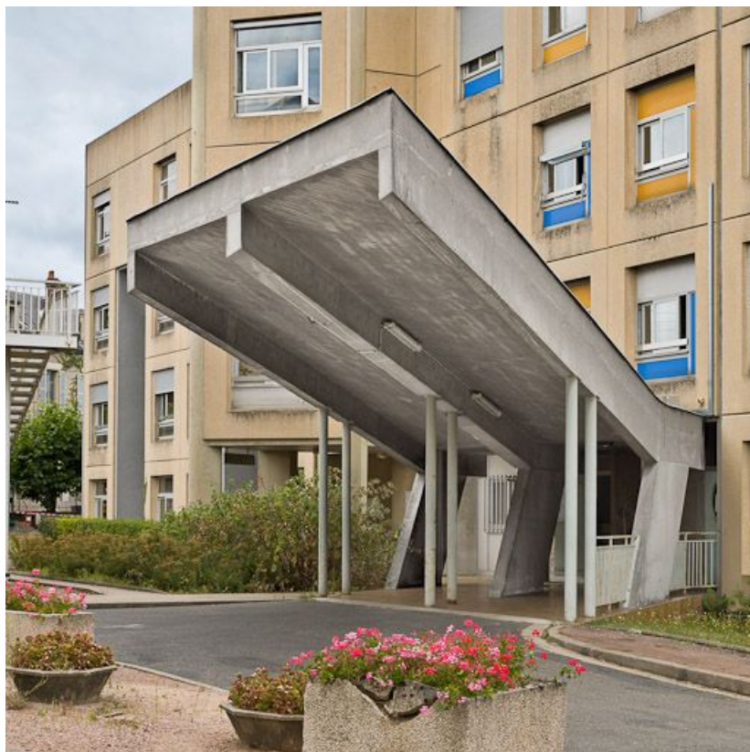
Bâtiment Maternité-Gynécologie (Gérontologie au moment de la prise de vue) : détail de l'auvent de la façade antérieure. 58, Nevers Colbert
