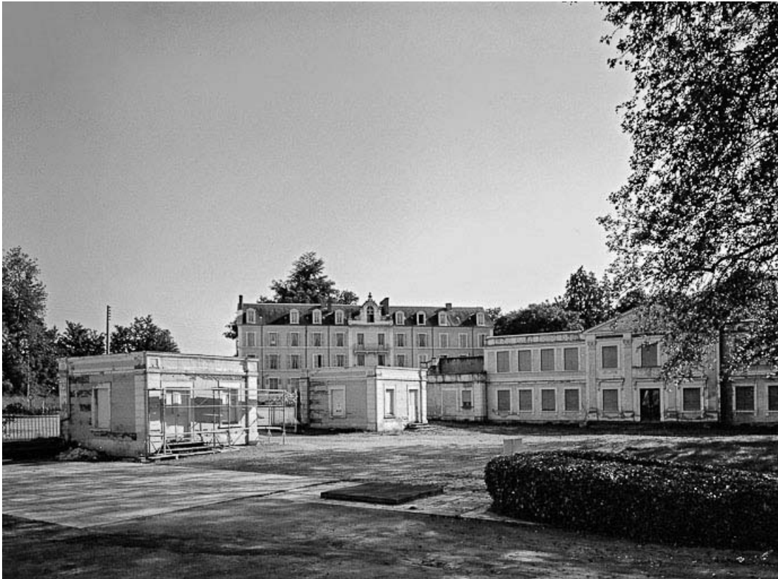
Pavillons d'entrée, bâtiment thermal Saint-Léger et ancien hôtel situé en face de l'établissement. 58, Pougues-les-Eaux, 23-25 avenue de Conti
