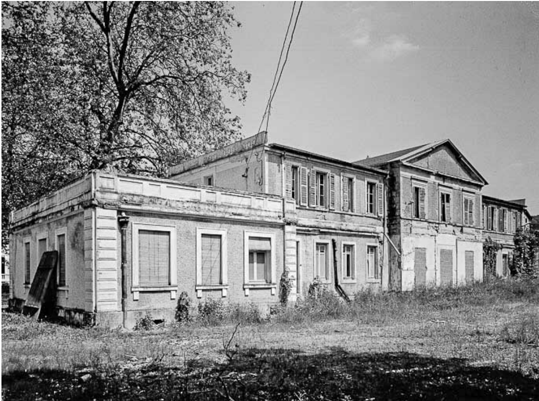
Bâtiment thermal Saint-Léger, façade postérieure.
