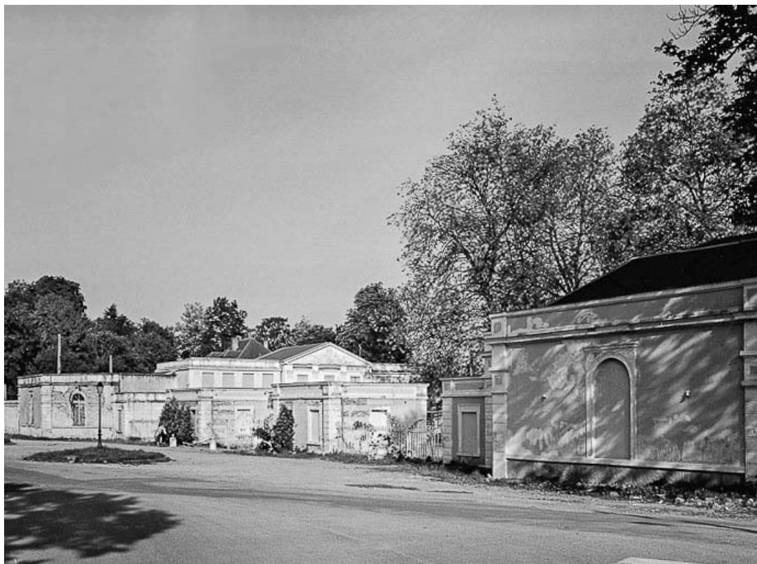
Pavillons d'entrée (salon d'accueil à gauche, administration à droite) et bâtiment thermal, vue prise de la rue. 58, Pougues-les-Eaux, 23-25 avenue de Conti
