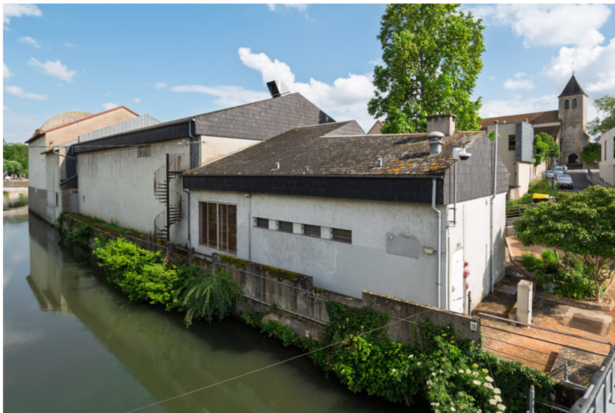
Façade latérale droite, depuis l'ouest : salle des fêtes.
