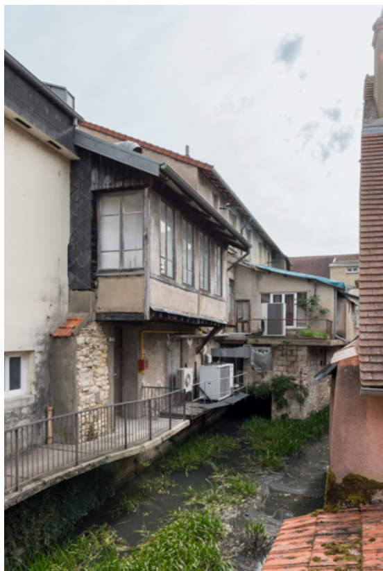
Façade latérale gauche, depuis l'ouest : cinéma.
