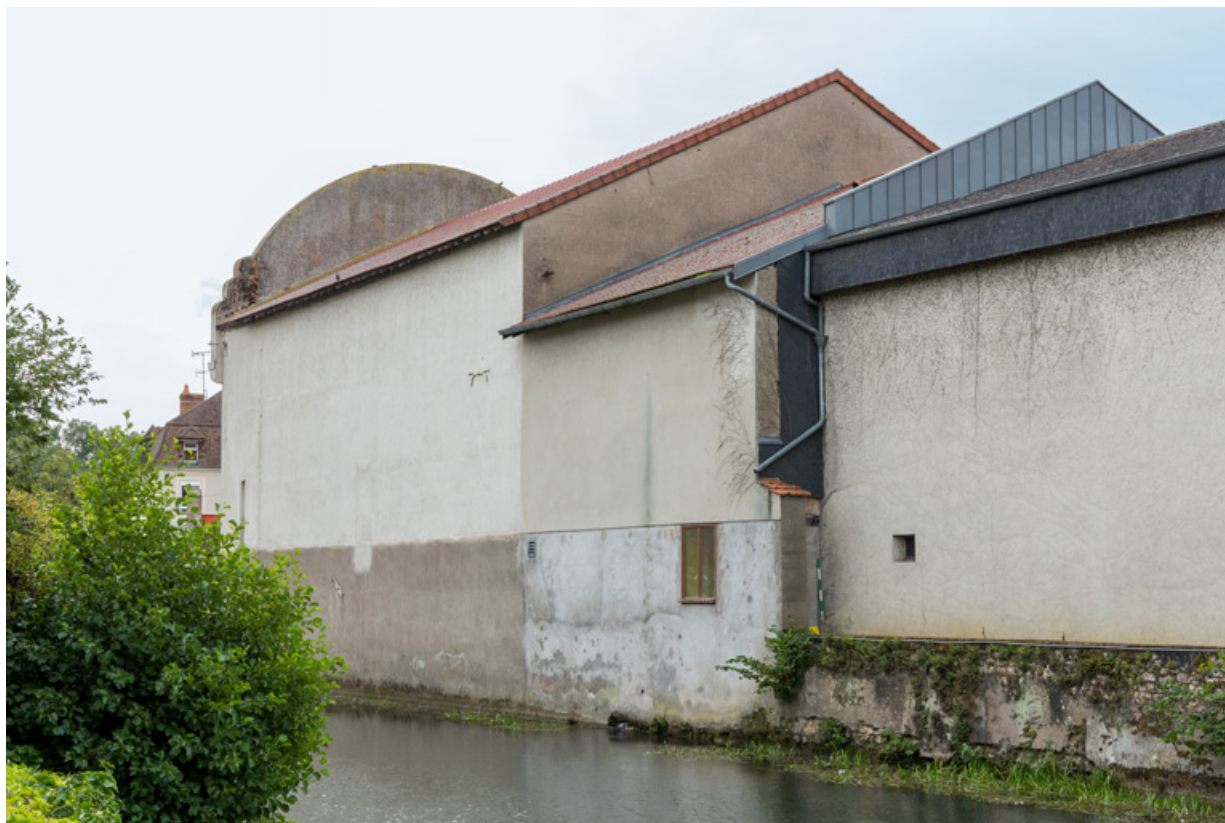
Façade latérale droite, depuis l'ouest : cinéma.
