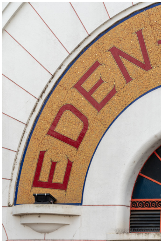
Façade antérieure, partie haute : détail de l'enseigne. 58, Cosne-Cours-sur-Loire, 2 rue Saint-Agnan
