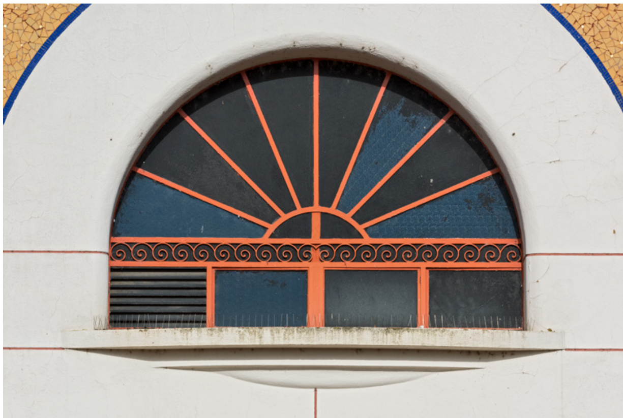
Façade antérieure, partie haute : baie.
