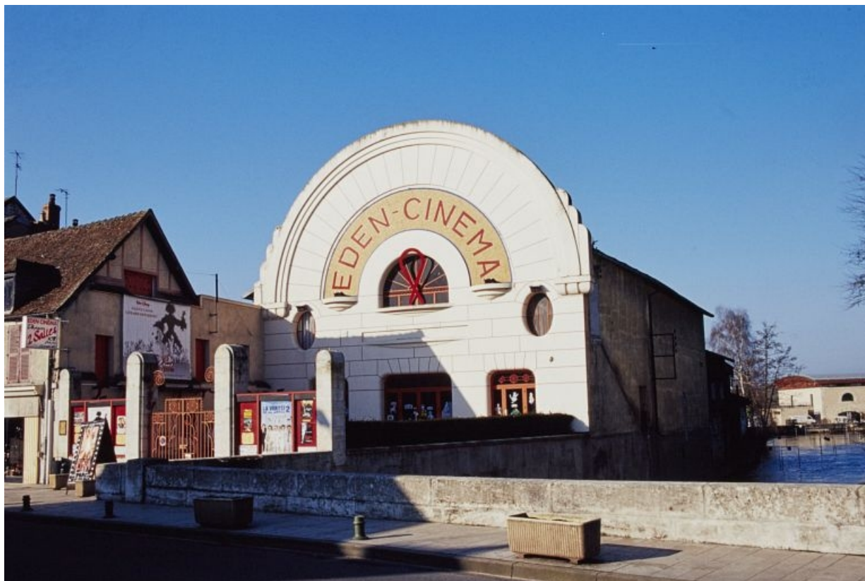
Élévation principale, vue d'ensemble, en 2001.
