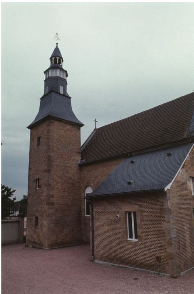
Vue d'ensemble du bâtiment, façade latérale droite.
