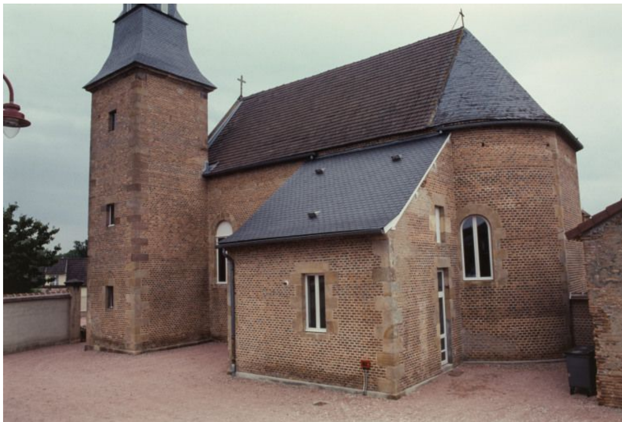
Vue d'ensemble du bâtiment, façade latérale droite.
