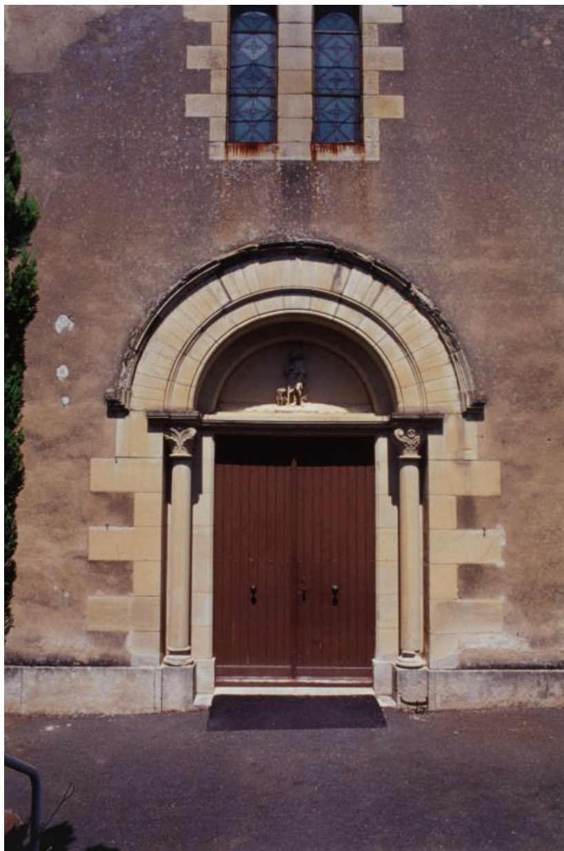
Chapelle, vue d'ensemble de la porte d'entrée.
