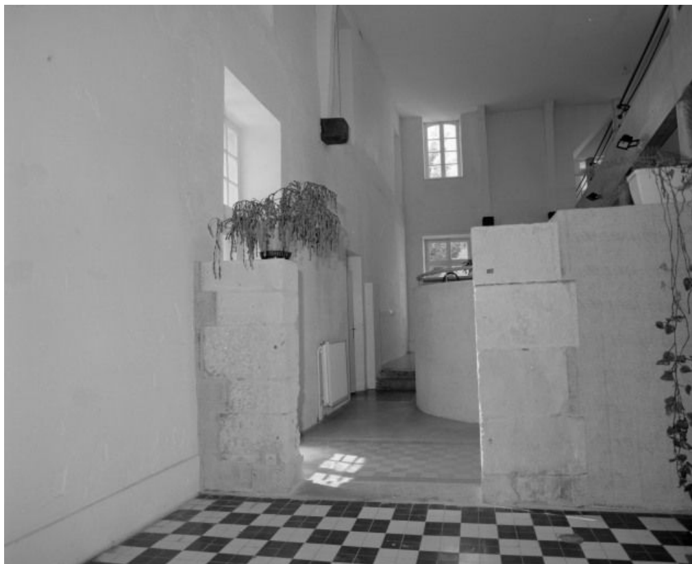
Aile gauche du bâtiment, détail du mur intérieur.
