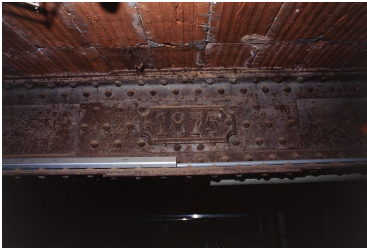
Détail d'une poutre de l'atelier, datée 1875.
