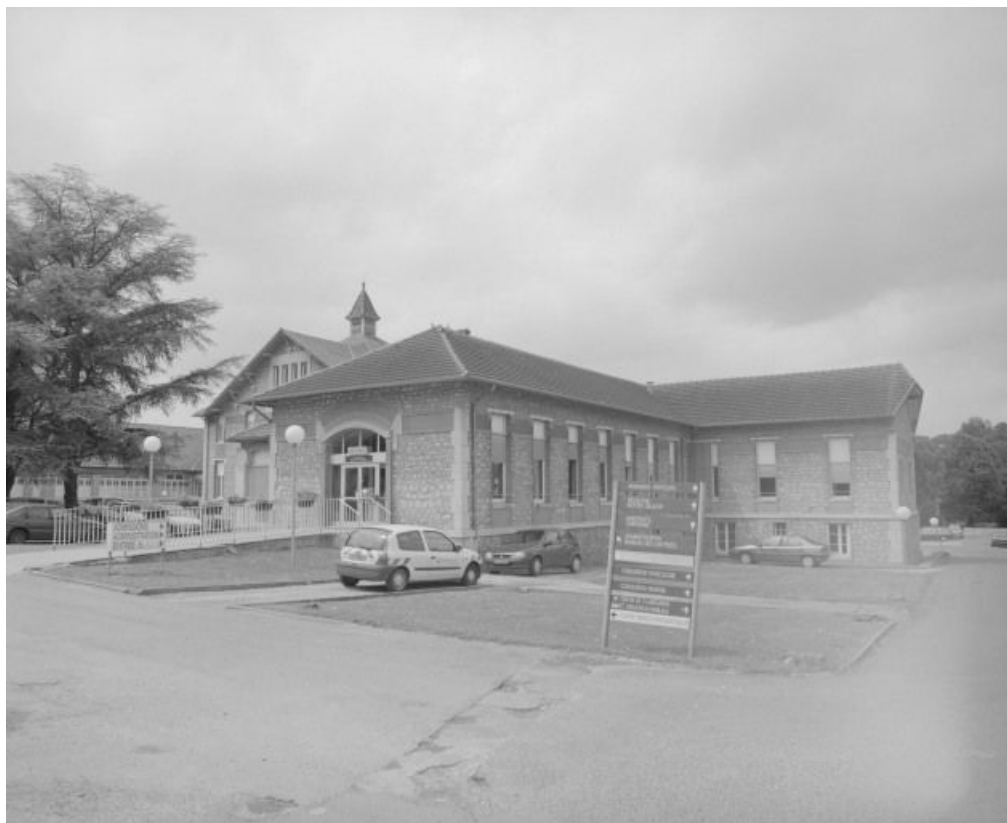
Vue d'ensemble de la partie droite du bâtiment principal.
