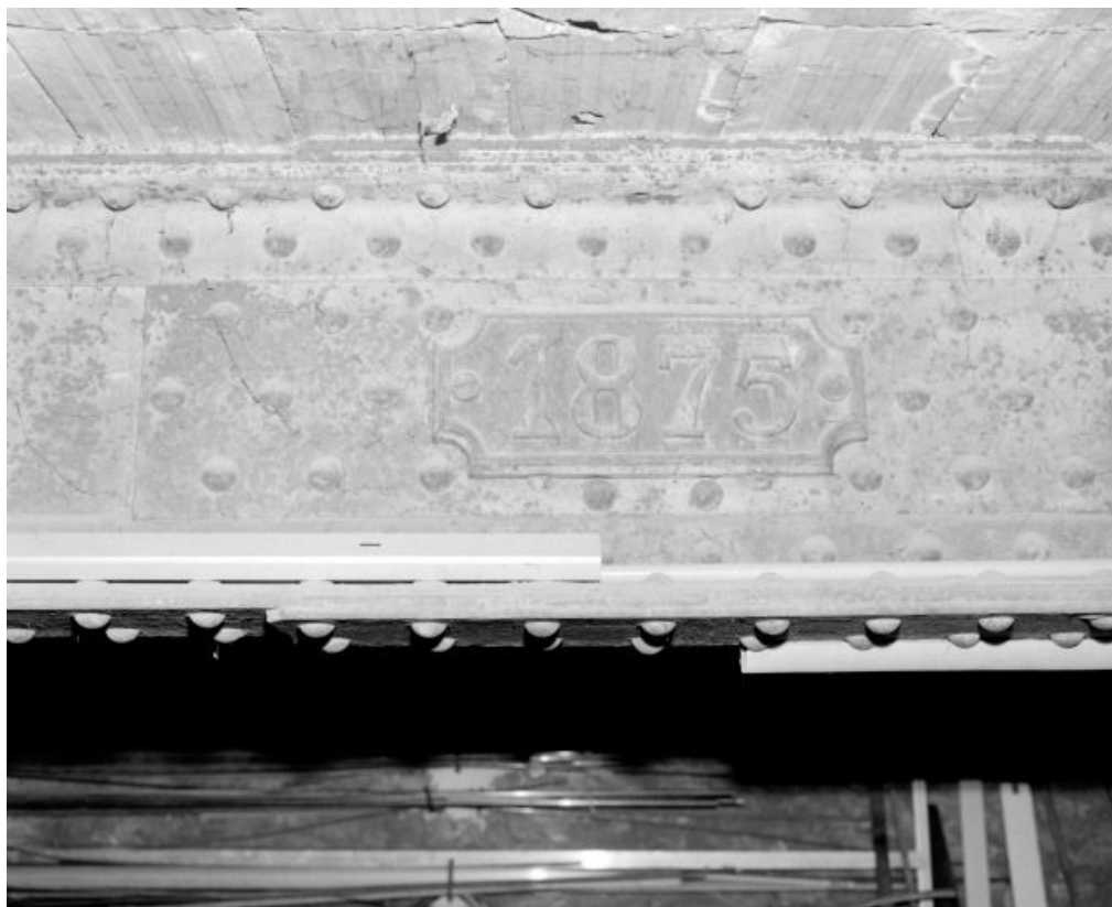
Détail d'une poutre de l'atelier, datée 1875.
