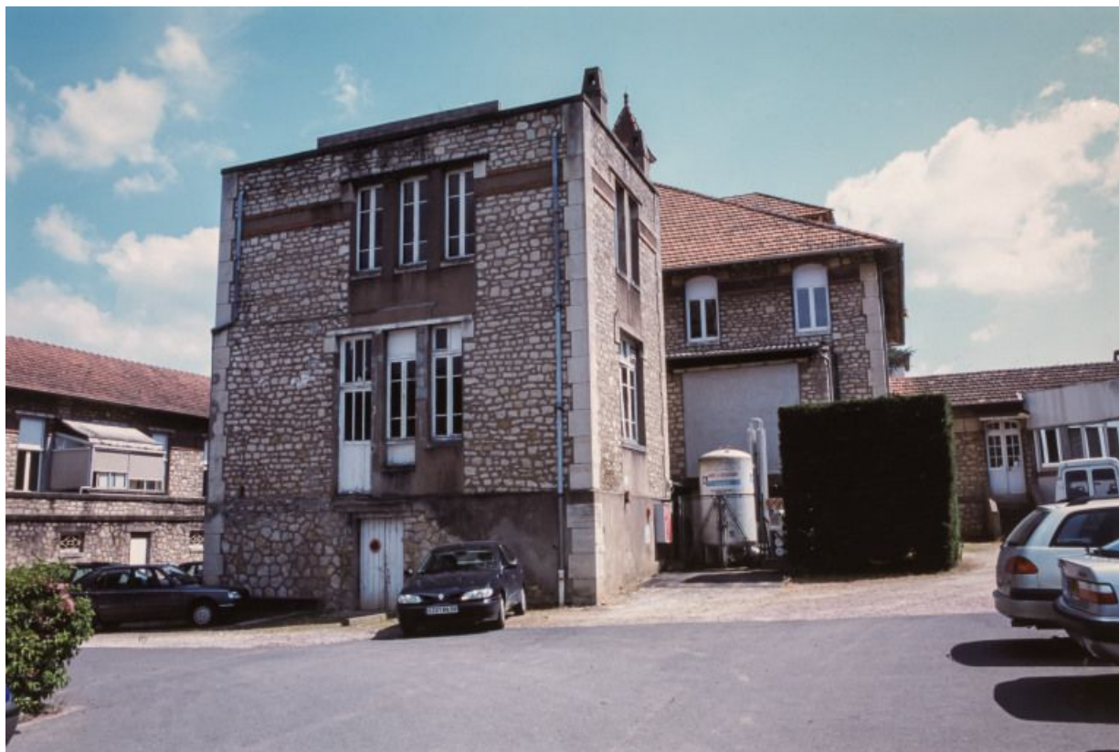
Bâtiment principal, façade postérieure (ancienne cuisine).
