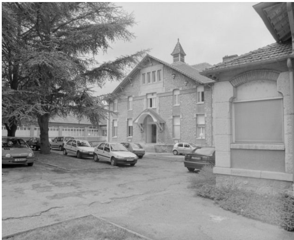
Vue d'ensemble de la façade antérieure du bâtiment principal.
