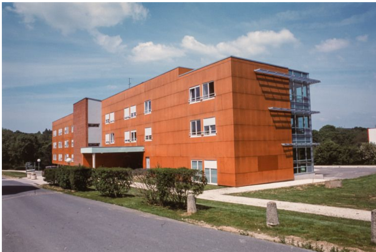
Maison de retraite, vue de trois quarts droit.
