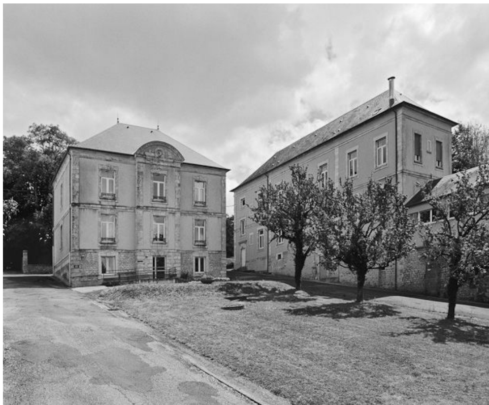
Pavillon central et aile du bâtiment droit.
