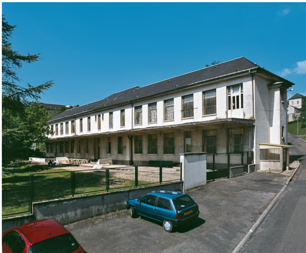
Bâtiment des malades en résidence, façade antérieure.
