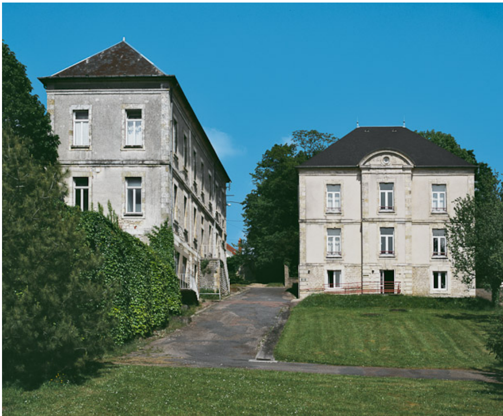
Vue générale du bâtiment principal et d'un bâtiment de soin.
