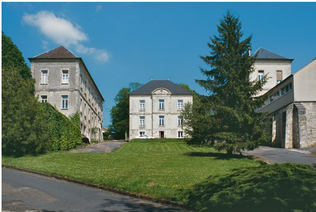
Pavillon central et ailes des deux bâtiments en U.
