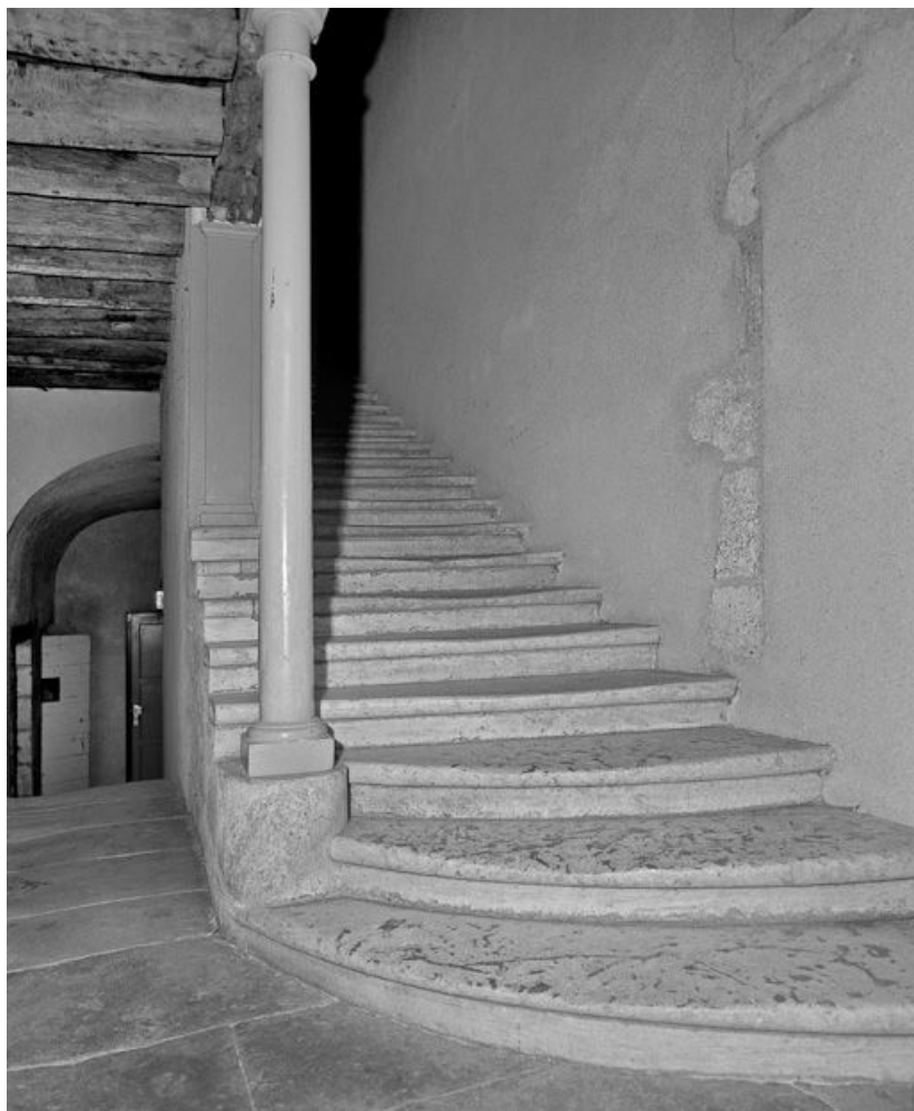
Vue de l'escalier du cloître.
