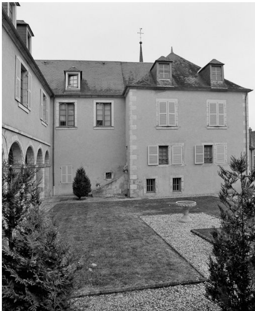
Élévation sur la cour d'honneur de l'aile ouest du bâtiment principal.
