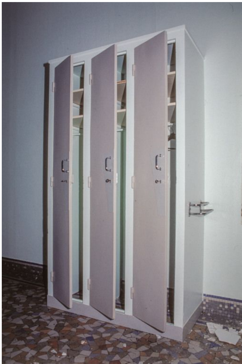
Bâtiment principal, 1er étage, chambre à 4 ou 6 lits. 58, Cosne-Cours-sur-Loire, 96 rue du Maréchal-Leclerc
