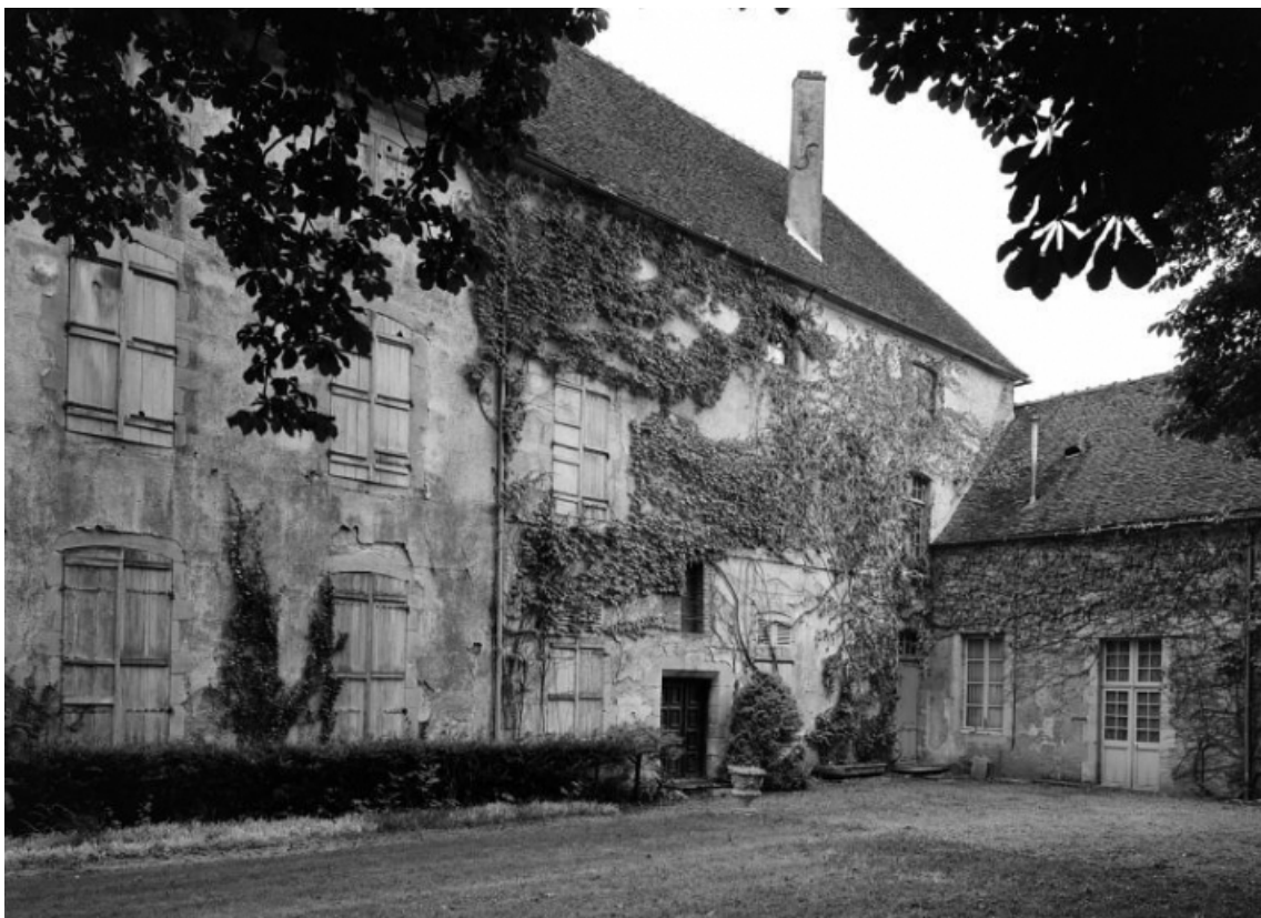
Bâtiment est. Façade prise du nord-est.
