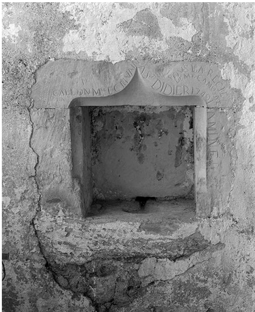
Lavabo du mur droit de la nef, près de l'autel.
