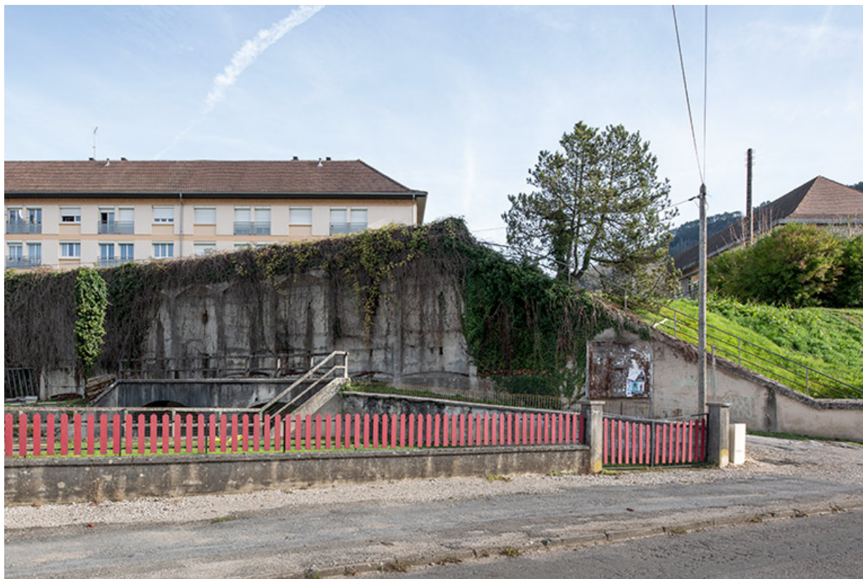
Partie sud du mur de soutènement et débouché de la rivière.
