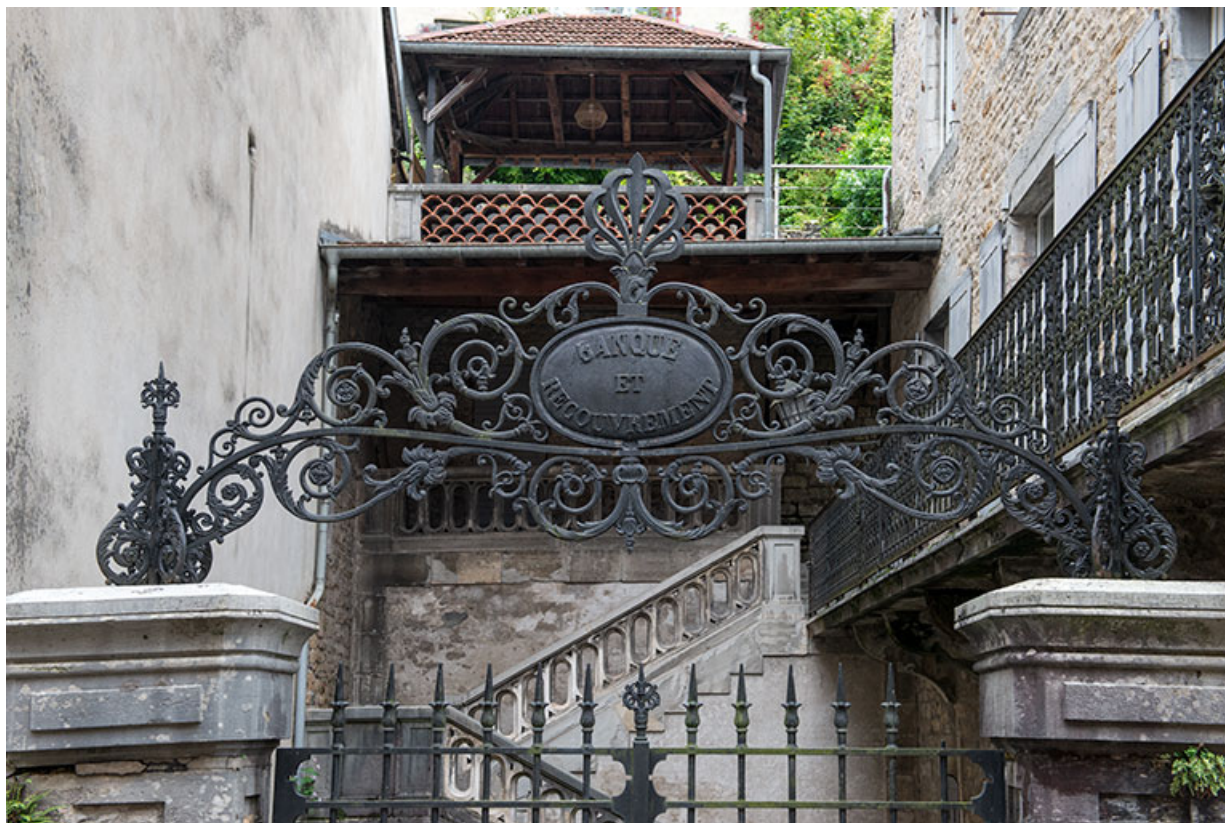
Porte sur cour. Partie supérieure de la ferronnerie.
