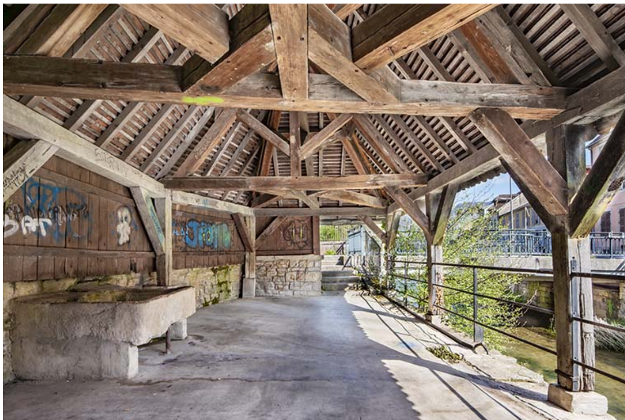
Vue de la charpente, depuis le sud.
