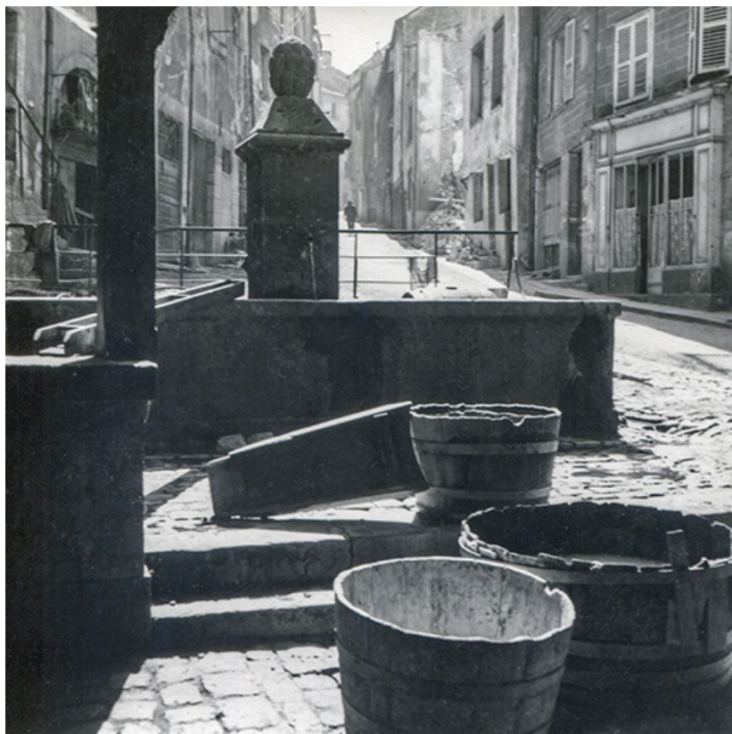
La fontaine vue depuis le lavoir, s.d. [années 1960 ?]. 39, Salins-les-Bains rue d' Olivet
