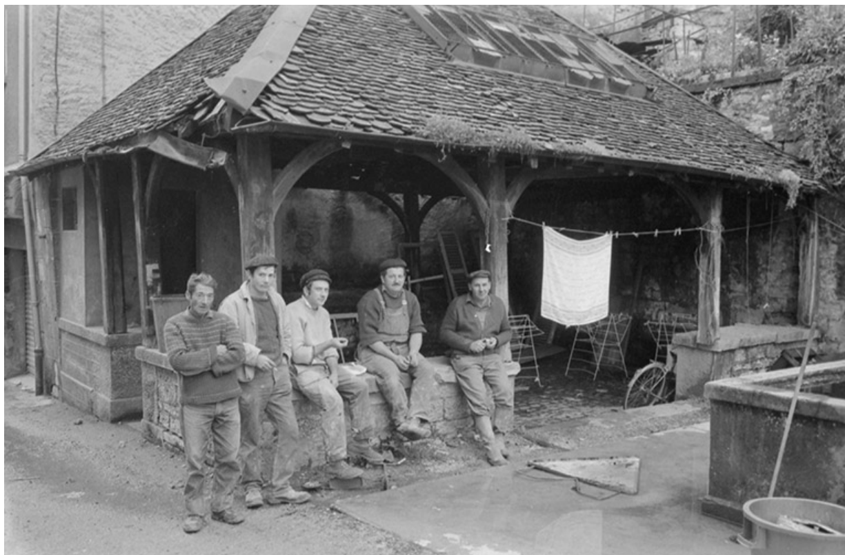
Démolition du quartier de Saint-Maurice. Des ouvriers posent devant le lavoir, s.d. [vers 1973]
