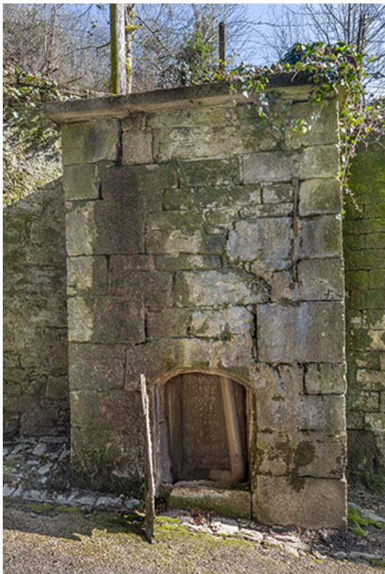
Escalier de Saint-Anatoile. Vue rapprochée du captage. 39, Salins-les-Bains
