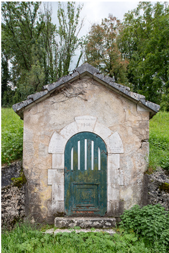
Réservoir de Veley (1910). Façade nord. 39, Salins-les-Bains
