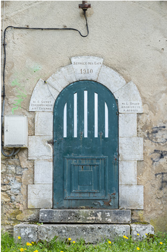
Réservoir de Chambenois, 1910. Porte du réservoir. 39, Salins-les-Bains
