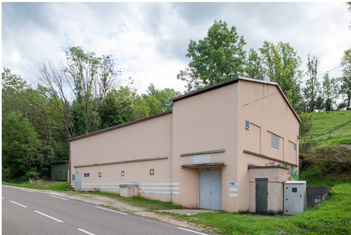
Station de stérilisation (1937), R.D. 472. 39, Salins-les-Bains
