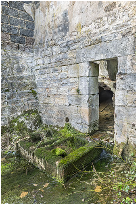
Source d'Arele (entrée nord de la ville, R.D. 472) 39, Salins-les-Bains
