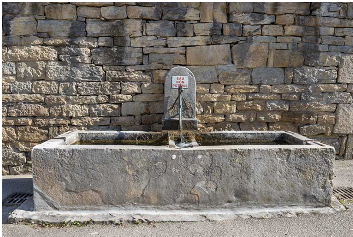
Fontaine située à l'entrée ouest de la rue des Prémoureux (vers 1854). 39, Salins-les-Bains
