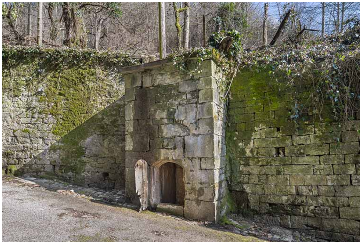
Escalier de Saint-Anatoile. Captage d'une source.
