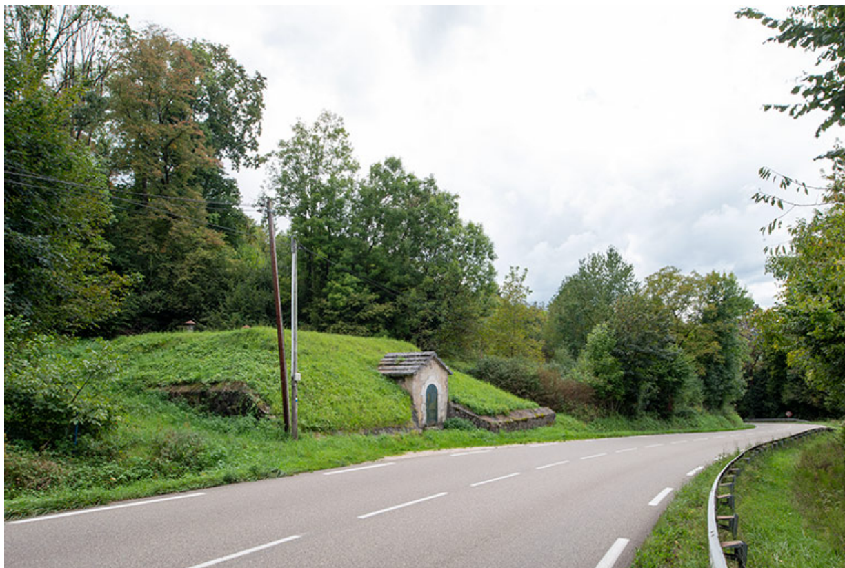
Réservoir de Veley (1910), R.D. 472. Vue depuis l'est. 39, Salins-les-Bains
