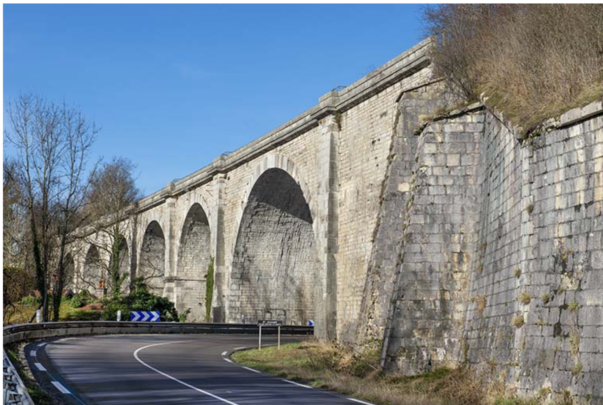
Vue depuis la route départementale, à l'est. 39, Salins-les-Bains, lieudit : Saint-Joseph
