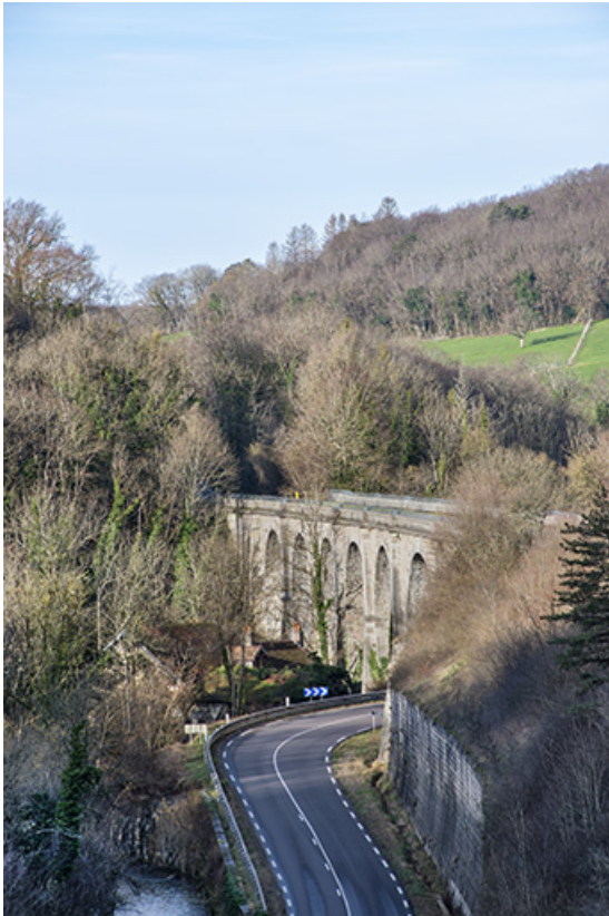
Vue rapprochée du viaduc, depuis l'est. 39, Salins-les-Bains, lieudit : Saint-Joseph
