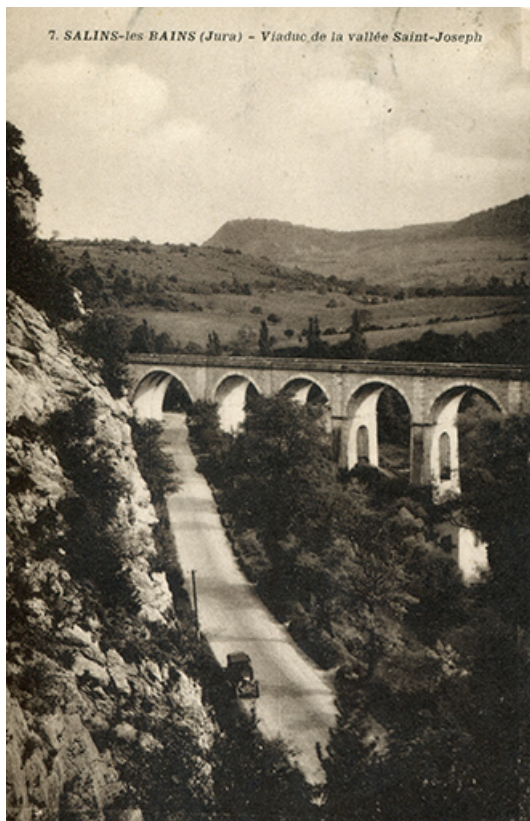
Salins-les-Bains (Jura) - Viaduc de la vallée de Saint-Joseph, s.d. [début 20e siècle]. 39, Salins-les-Bains, lieudit : Saint-Joseph
