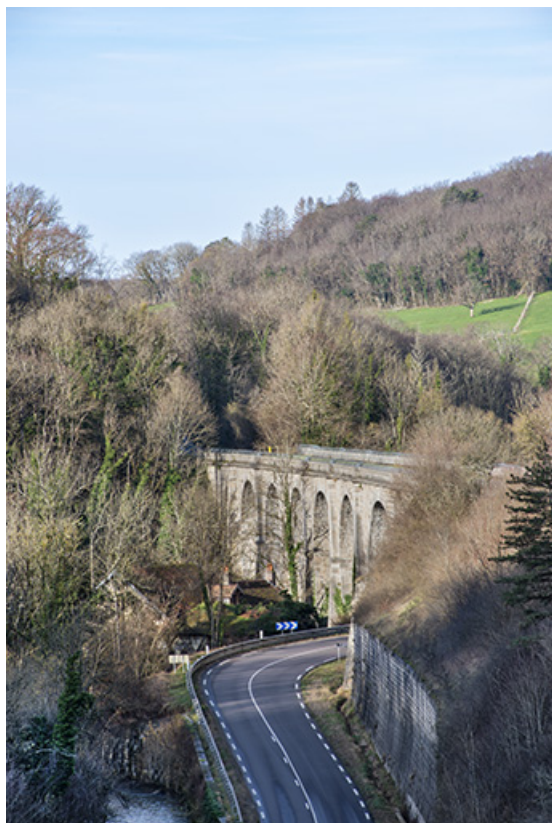
Vue rapprochée du viaduc, depuis l'est.
