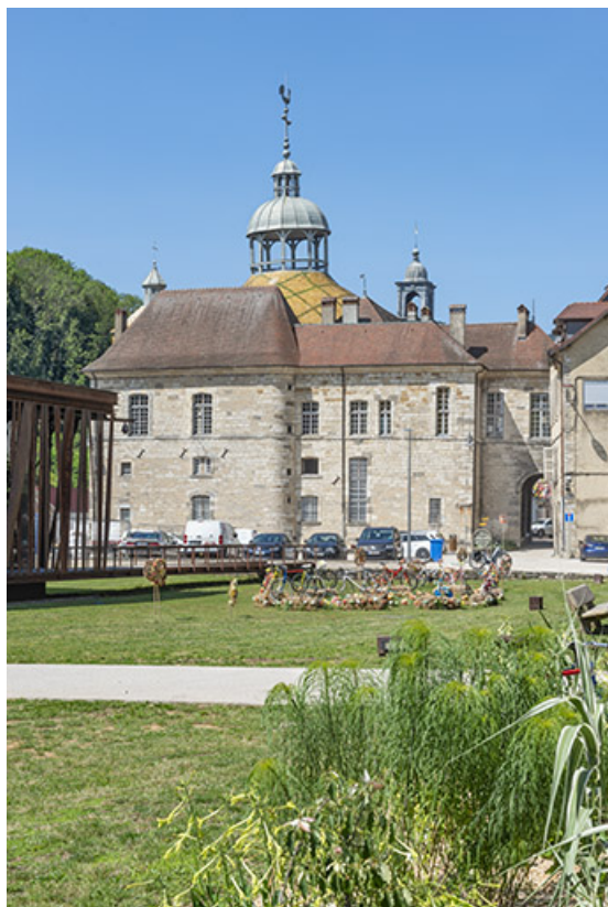
Façade sud, depuis l'esplanade des salines.
