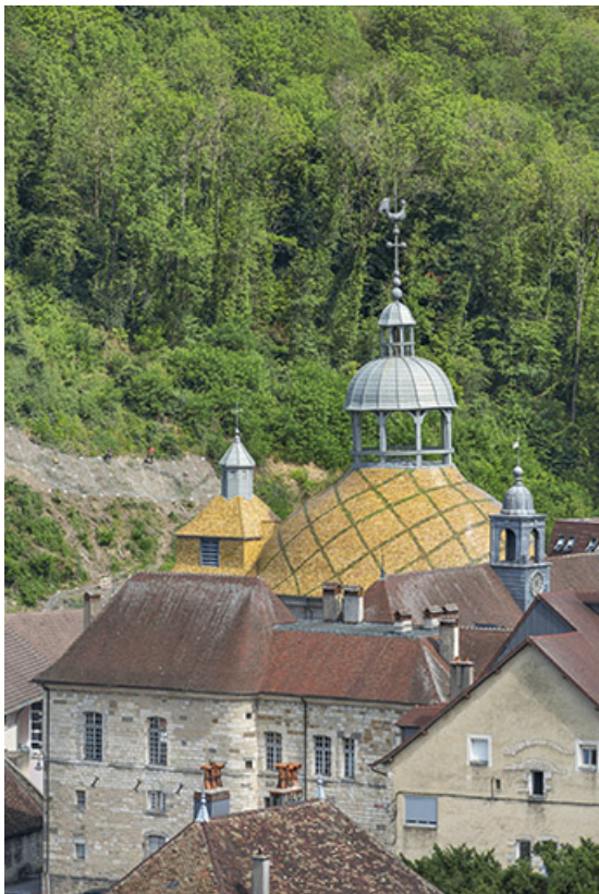
Vue plongeante depuis le sud-est.
