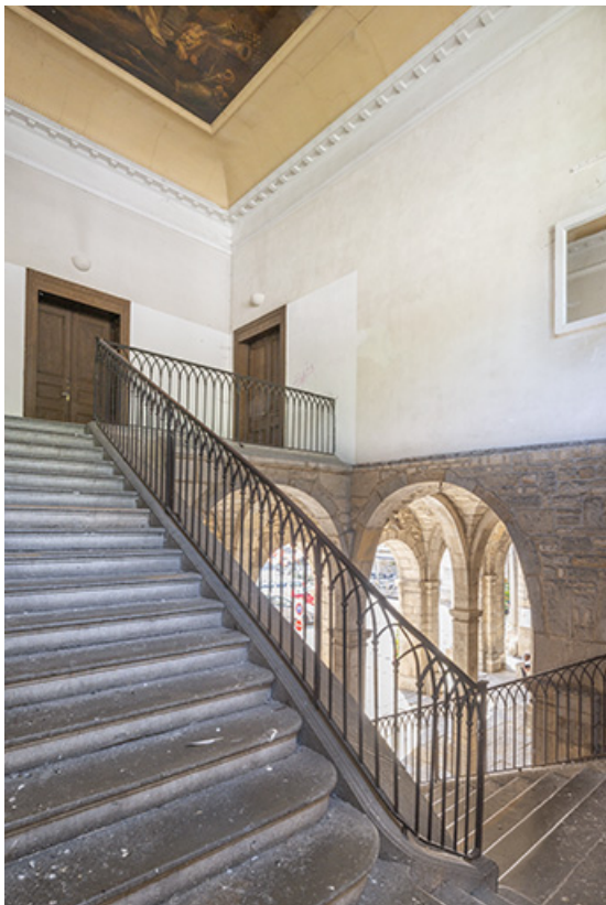
Aile nord. Vue de l'escalier de la mairie depuis le palier. 39, Salins-les-Bains place des Alliés et de la Résistance
