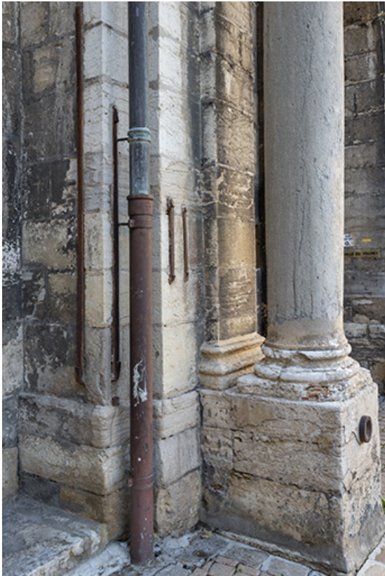
Toises métalliques (piédroit du passage couvert, corps de bâtiment principal). 39, Salins-les-Bains place des Alliés et de la Résistance
