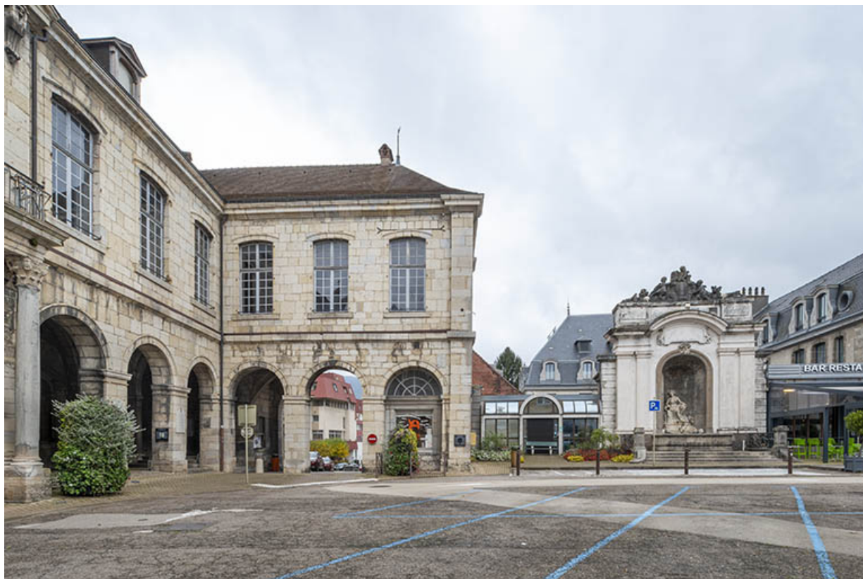
Aile nord, vue depuis le sud de la place.
