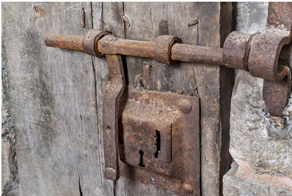
Porte de cellule. Détail d'un verrou.
