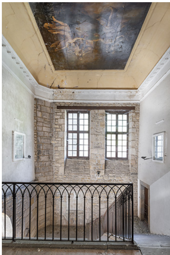
Aile nord. Cage d'escalier de la mairie.
