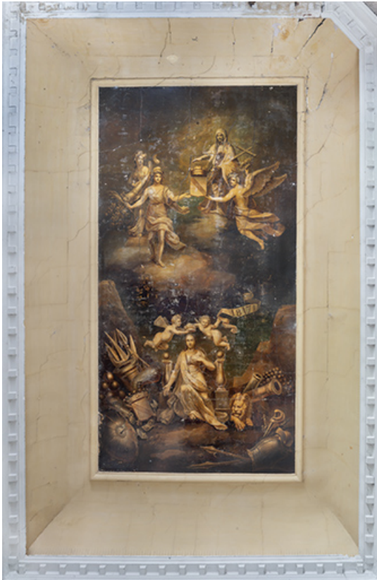
Aile nord. Peinture de plafond dans la cage d'escalier de la mairie. 39, Salins-les-Bains place des Alliés et de la Résistance
