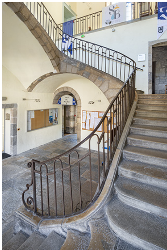
Escalier de l'ancien tribunal. Vue depuis le premier palier.
