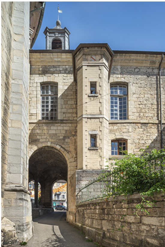
Élévation de la partie sud. Tour d'escalier hors-oeuvre. 39, Salins-les-Bains place des Alliés et de la Résistance
