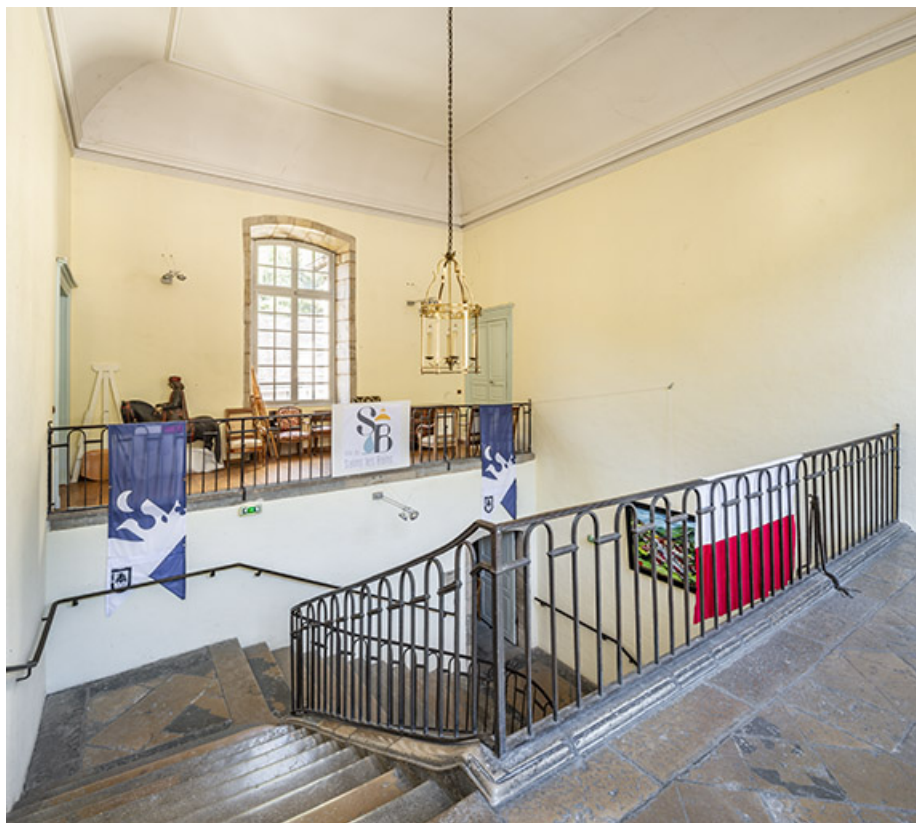
Escalier de l'ancien tribunal, vu depuis l'étage.
