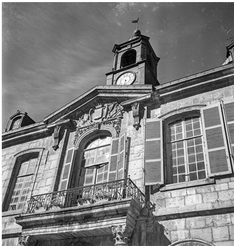
Travée centrale et campanile, s.d. [3e quart 20e siècle]. 39, Salins-les-Bains place des Alliés et de la Résistance
