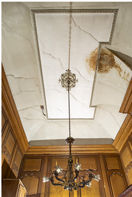
Plafond du bureau joutant l'ancienne salle du conseil.
