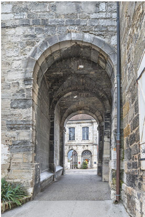
Aile sud. Passage couvert donnant sur la rue de la Tour de Flore.
