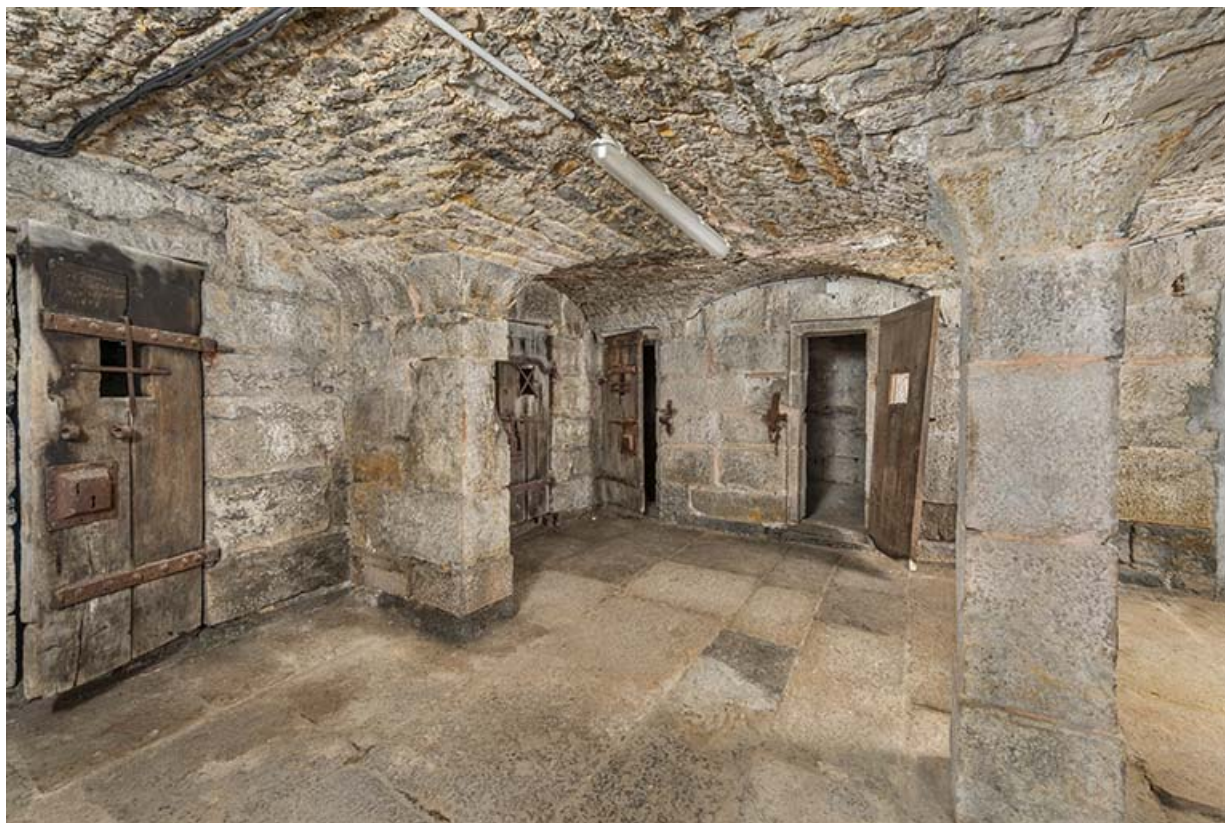
Vue d'ensemble du vestibule ouvrant sur les cellules (portes fermées).
