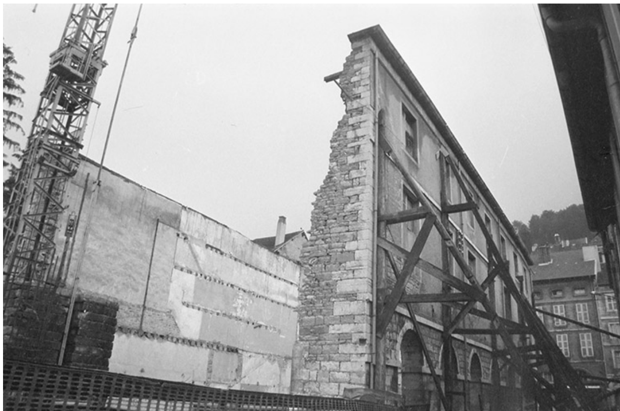
Le théâtre en chantier. Vue depuis le sud-ouest, s.d. [1988].
