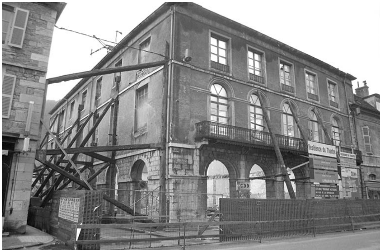
Le théâtre en chantier. Vue depuis le sud-est, s.d. [1988].
