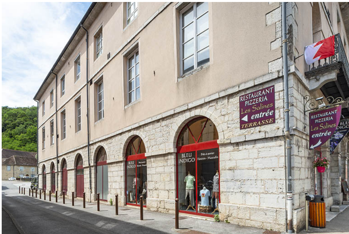
Façade sud, depuis la rue de la République. 39, Salins-les-Bains rue de la République
