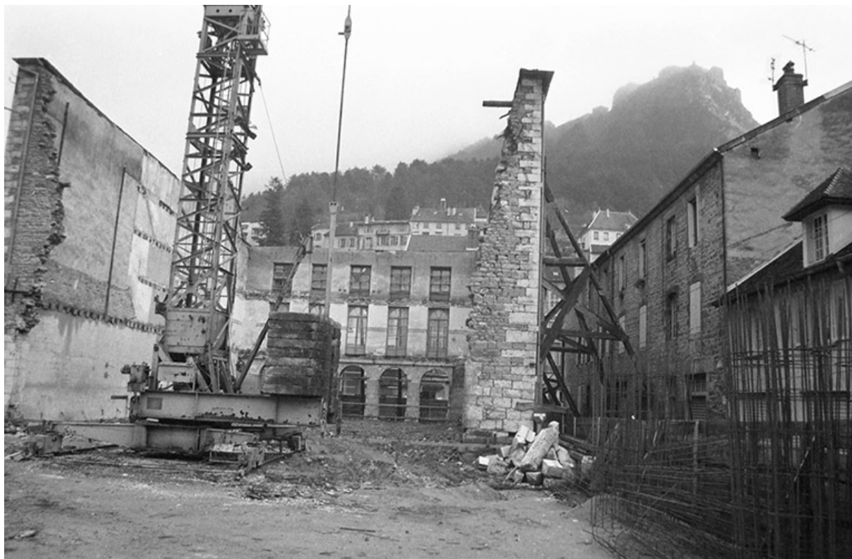
Le théâtre en chantier. Vue depuis l'ouest, s.d. [1988].
