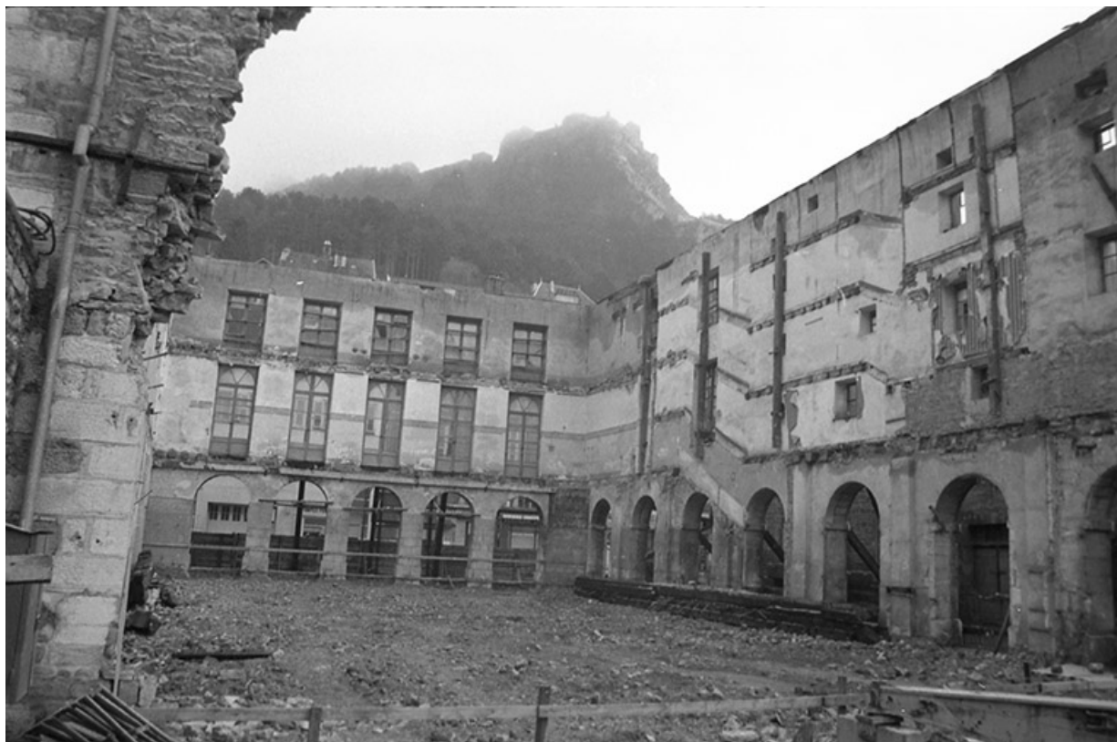
Le théâtre en chantier. Le bâtiment vidé, s.d. [1988].
