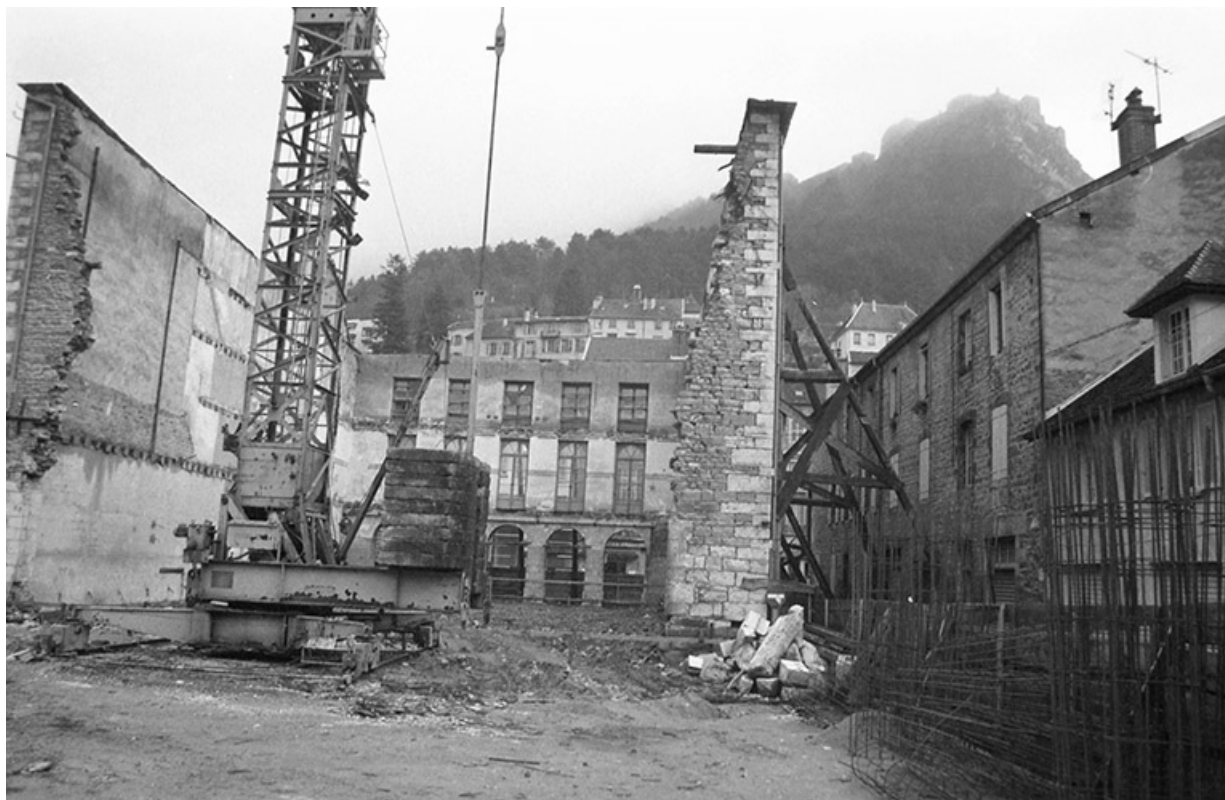
Le théâtre en chantier. Vue depuis l'ouest, s.d. [1988].
