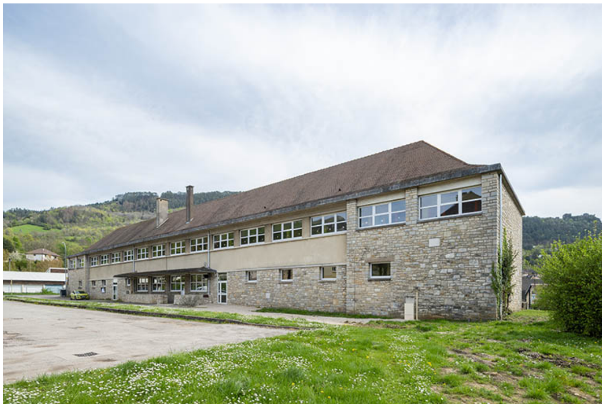
Façade nord, vue de trois quarts.
