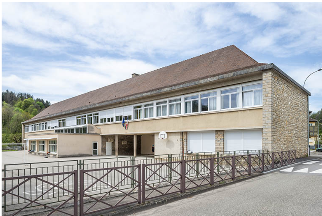
Vue depuis l'avenue Charles de Gaulle. 39, Salins-les-Bains, 2 rue Françoise Dolto
