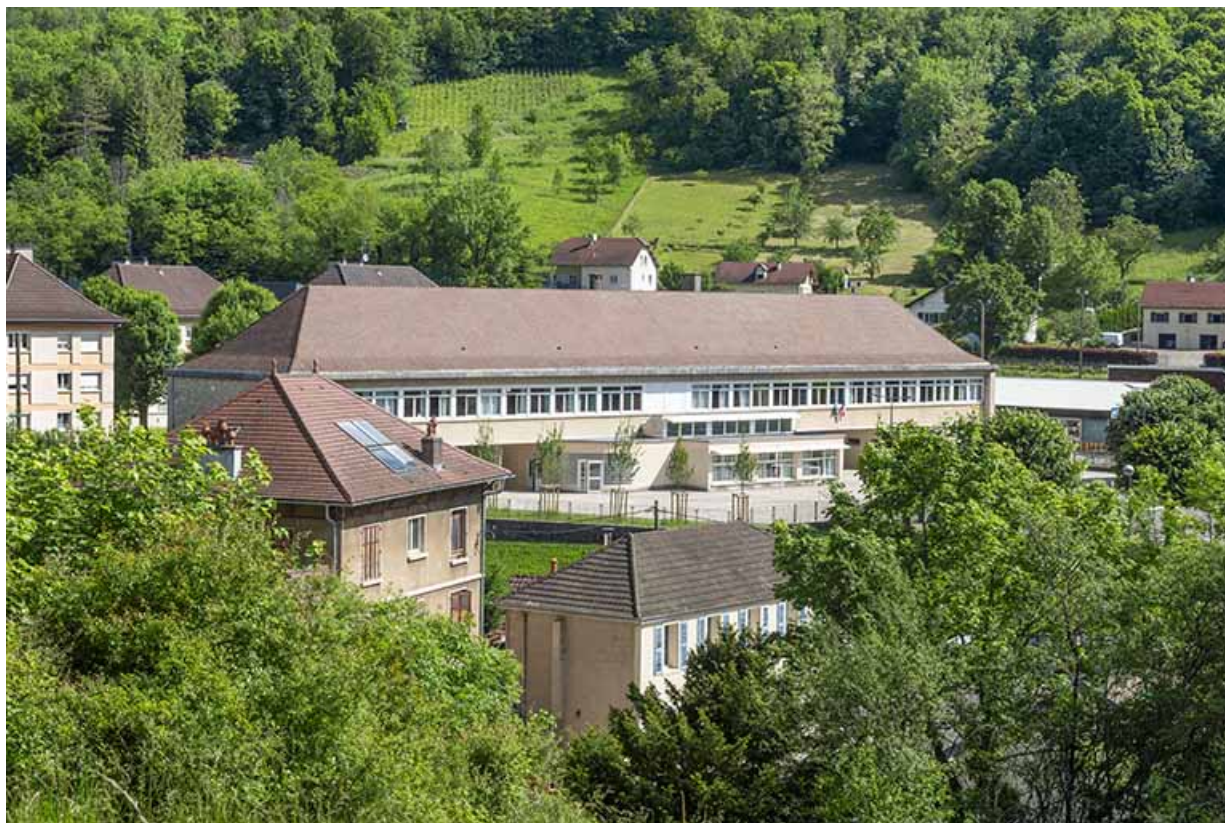
Vue d'ensemble, de trois quarts gauche. 39, Salins-les-Bains, 2 rue Françoise Dolto
