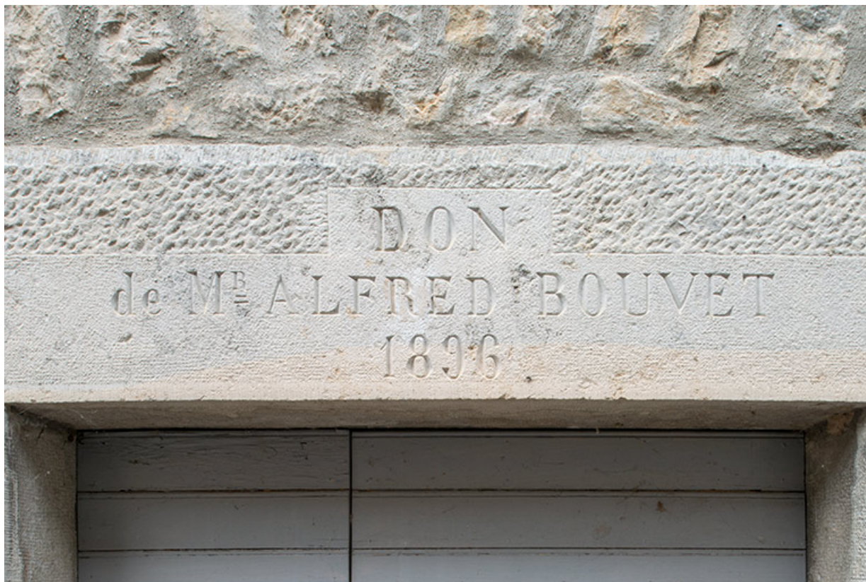
Façade sud. Détail du linteau de la porte.
