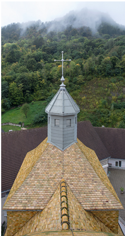
Toiture de la sacristie, depuis le lanterneau. 39, Salins-les-Bains place des Alliés
