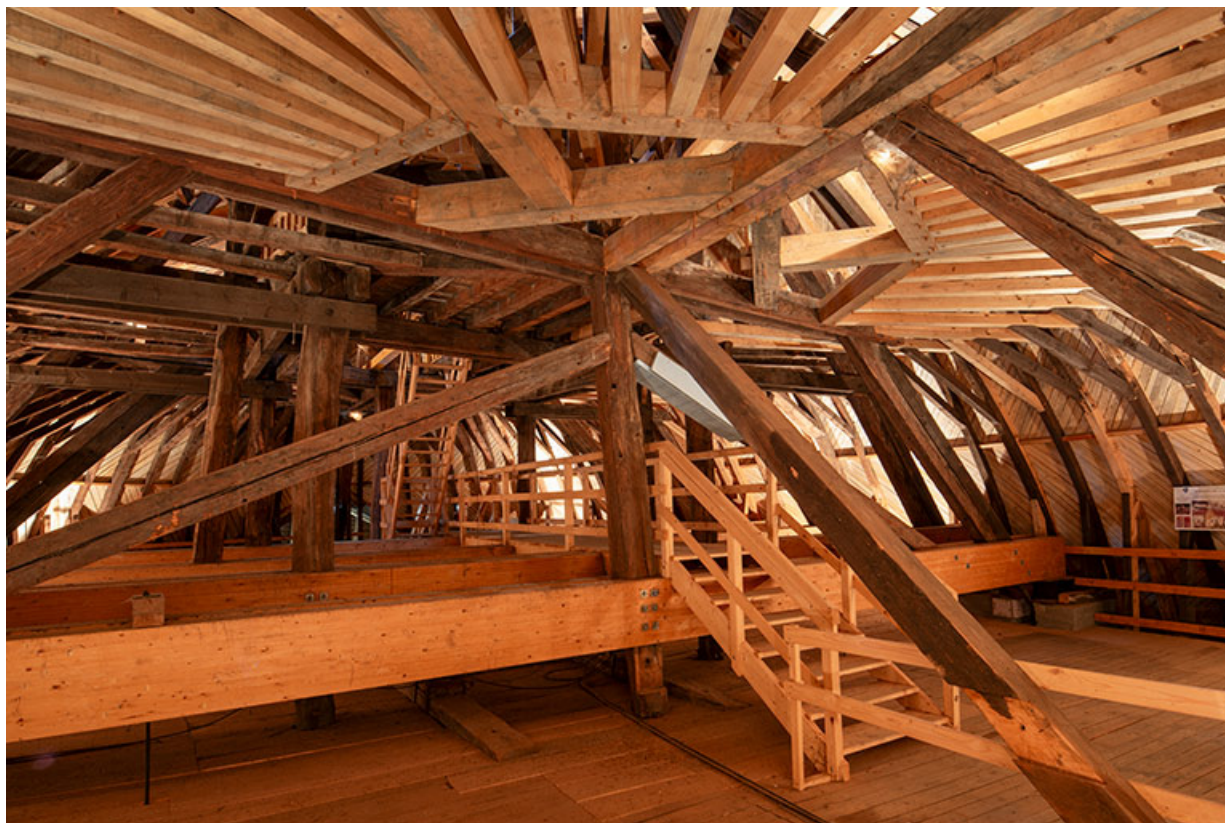
Vue d'ensemble depuis le nord-ouest. Vue rapprochée.
