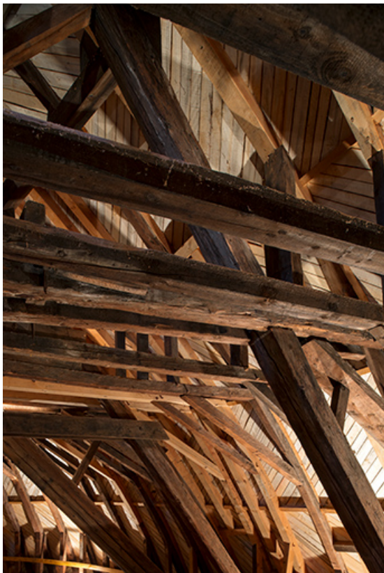
Coté sud, vu depuis l'ouest.
