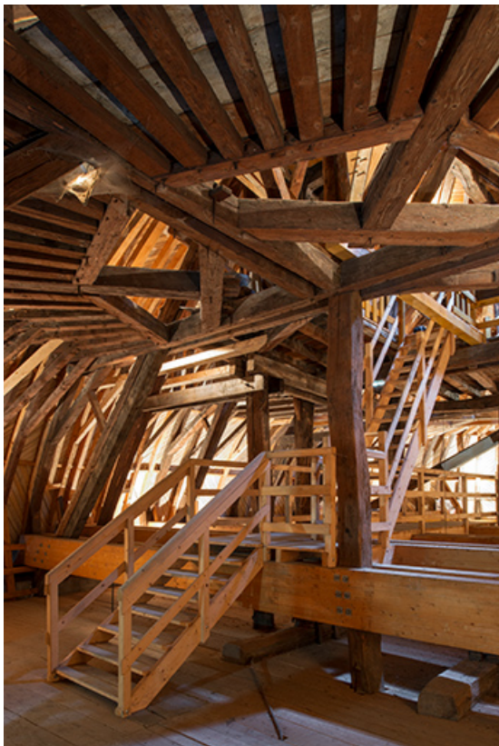
Vue de la charpente du dôme, depuis le nord-est.
