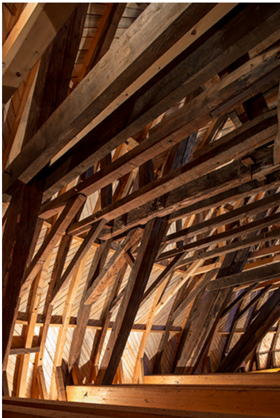
Partie sud de la charpente du dôme, vue de trois quarts.
