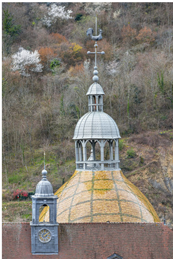
Vue de la coupole depuis l'est.
