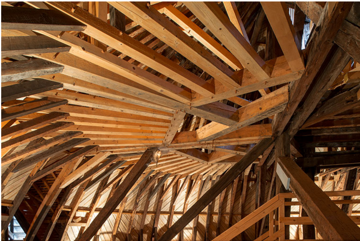
Enrayure du côté occidentale, depuis le sud. 39, Salins-les-Bains place des Alliés
