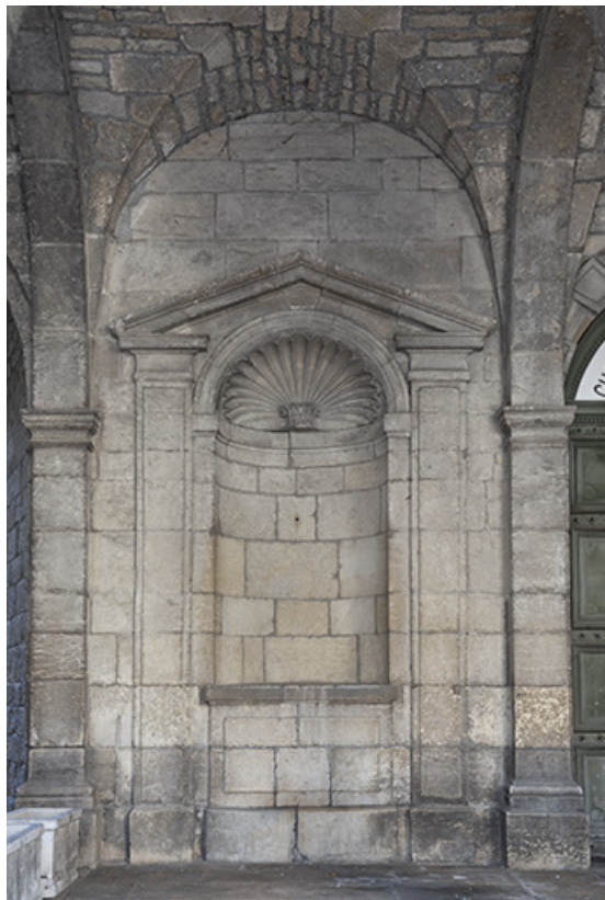
Façade antérieure du parvis. Niche sud.
