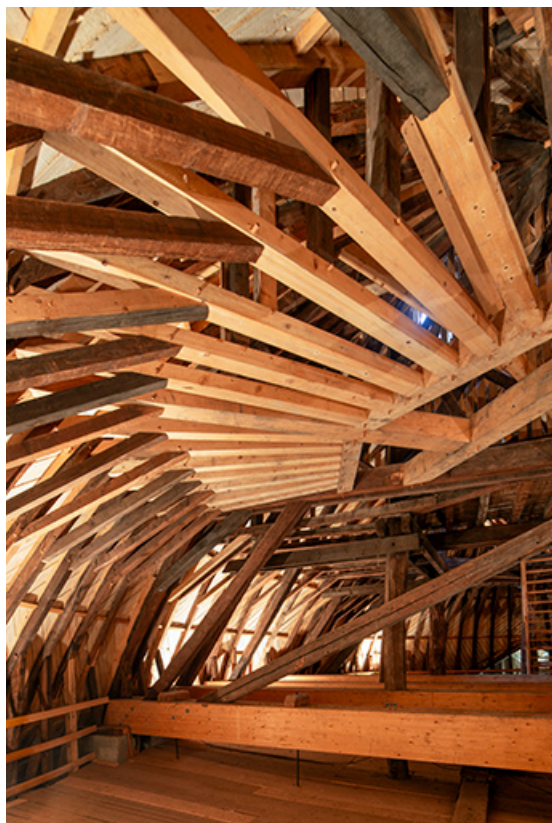
Coté nord, vu depuis l'ouest.
