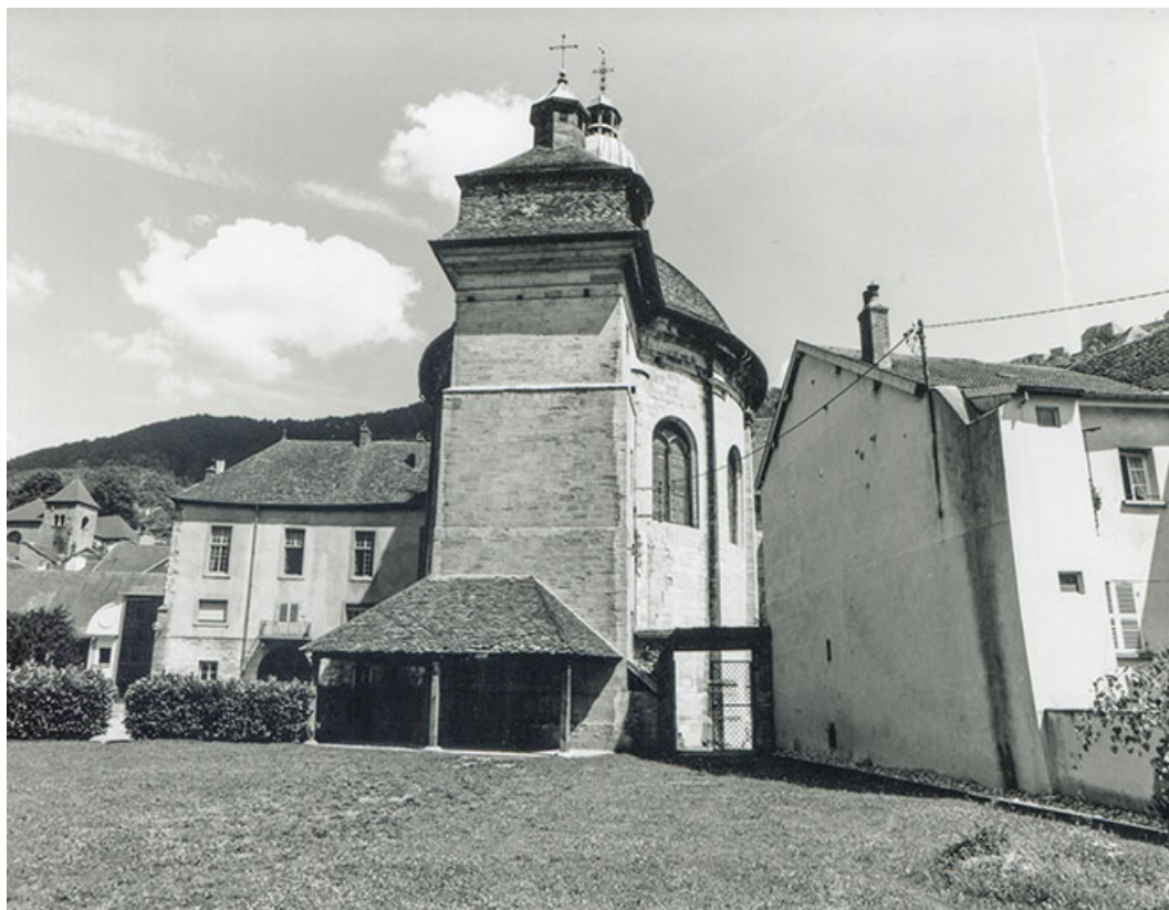
Vue depuis l'ouest, s.d. [vers 1980]. 39, Salins-les-Bains place des Alliés
