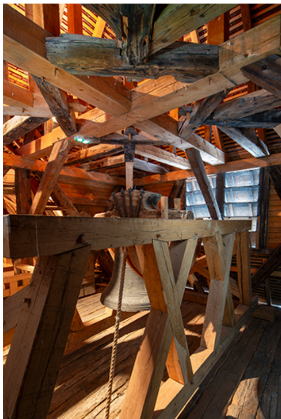
Campanile de la sacristie. Charpente du beffroi.
