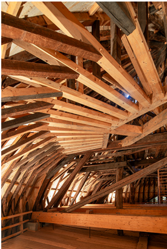
Coté nord, vu depuis l'ouest.
