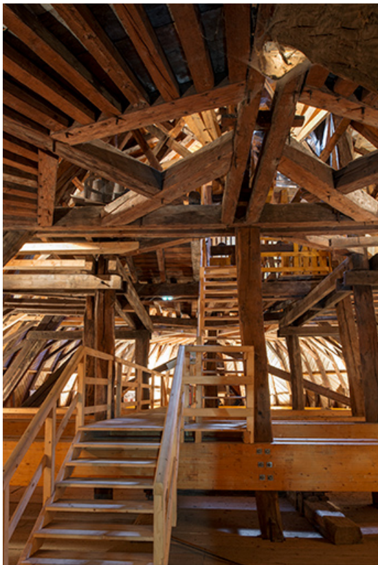
Vue axiale de la charpente du dôme, depuis l'est.
