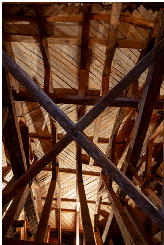
Partie nord depuis le niveau intermédiaire. Entretroise en croix de Saint-André. 39, Salins-les-Bains place des Alliés
