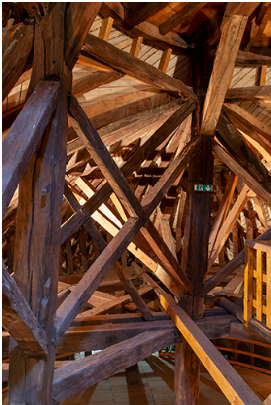
Entretoise du niveau intermédiaire, côté nord.
