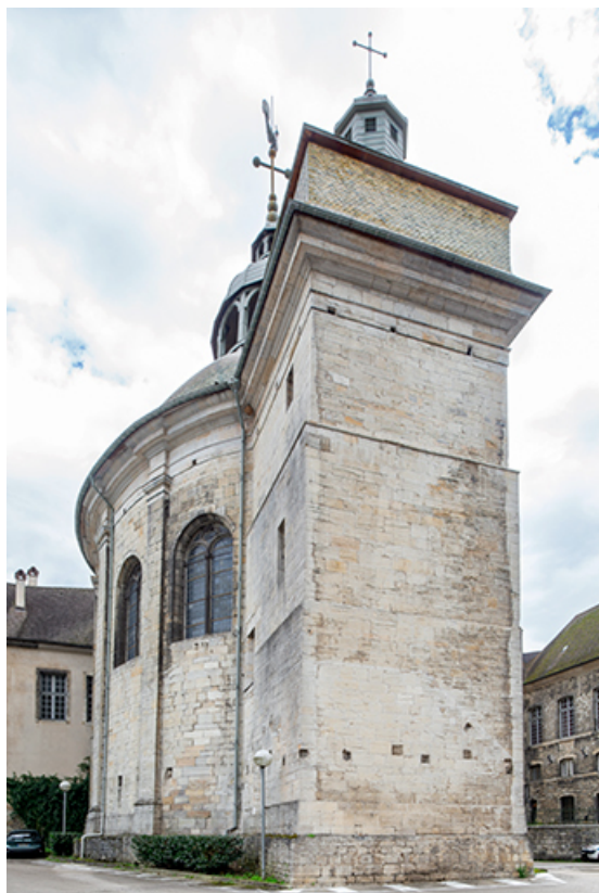
Vue depuis l'ouest : le chevet abritant la sacristie.
