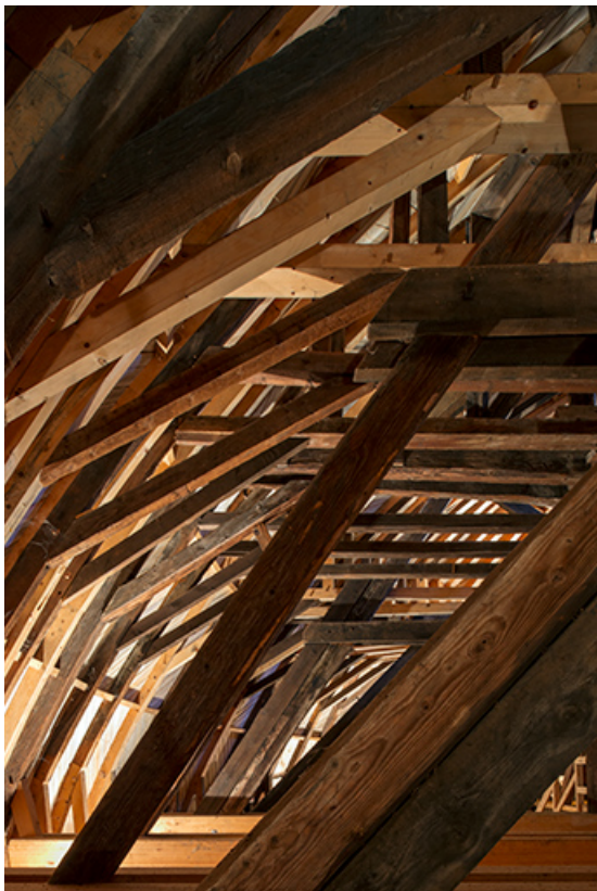
Côté sud de la charpente du dôme.
