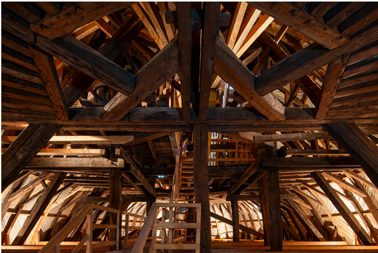
Vue axiale de la charpente du dôme, depuis l'est. Vue rapprochée.
