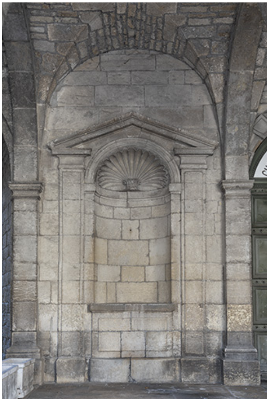
Façade antérieure du parvis. Niche sud.
