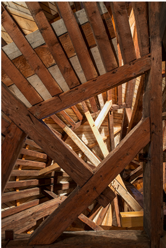
Enrayure nord-est de la charpente du dôme.
