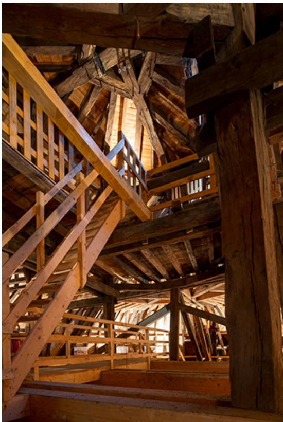
Beffroi du dôme, en contre-plongée, depuis l'est.
