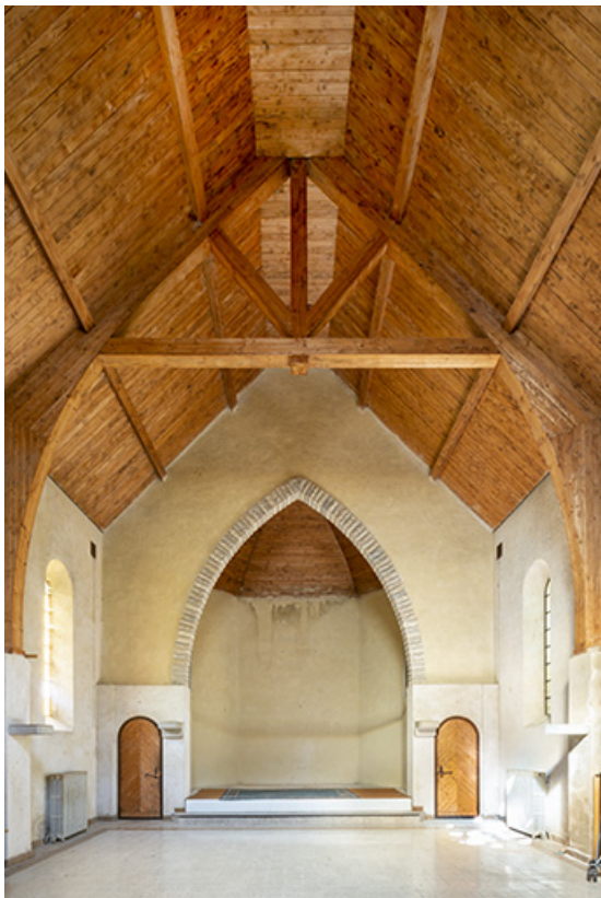
Vue intérieure, depuis l'est.
