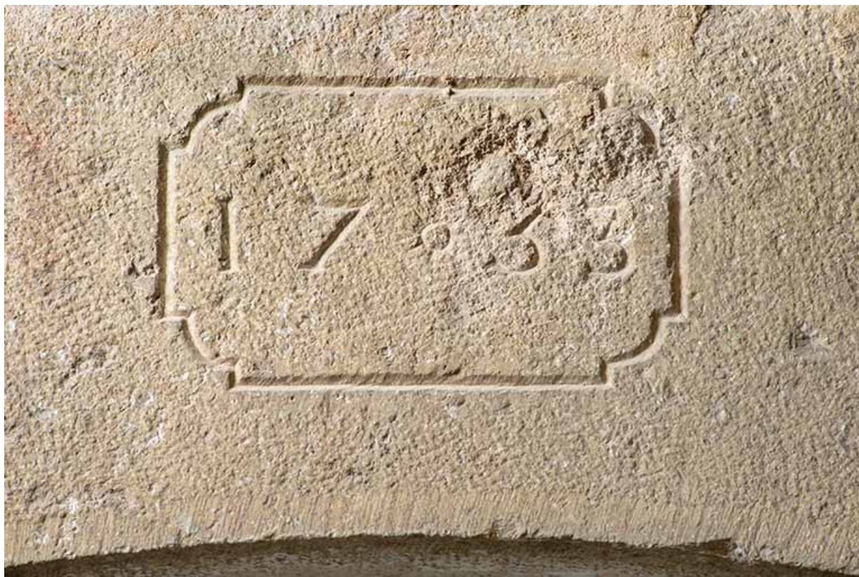
Mur est du bâtiment. Cartouche gravée (1753 ?)
