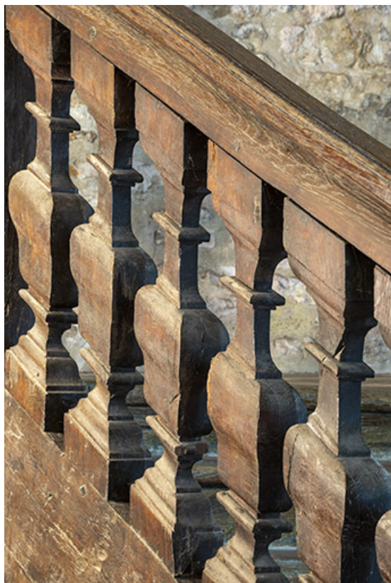
Extrémité orientale de l'aile nord. Détail des balustres.
