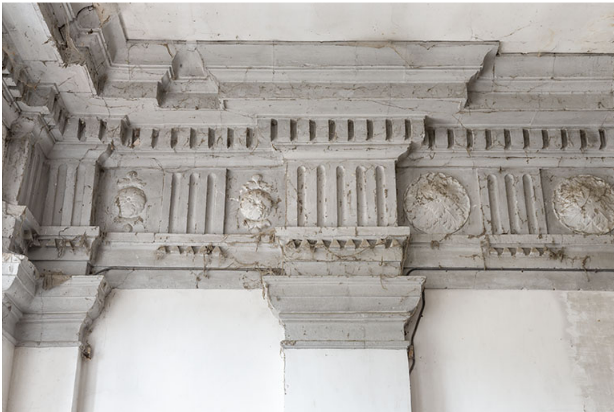
Entablement et corniche de la chapelle (mur nord).
