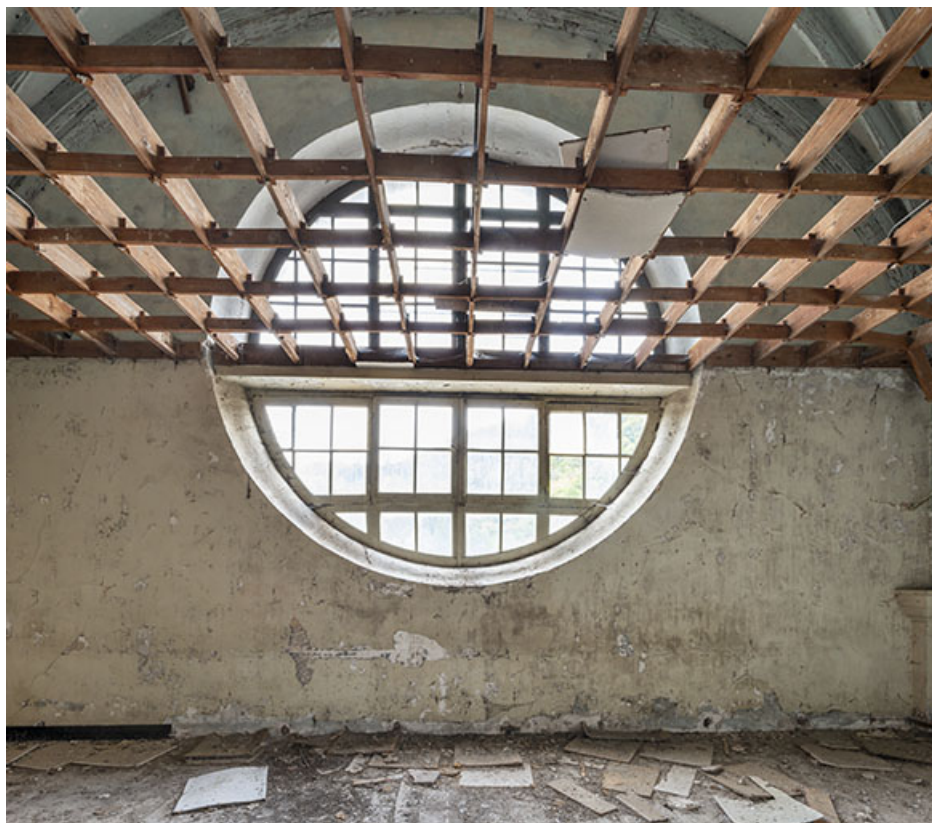
Vue intérieure de l'oculus (façade ouest), et ossature bois du plafond (salles de classe du collège). 39, Salins-les-Bains place Émile Zola
