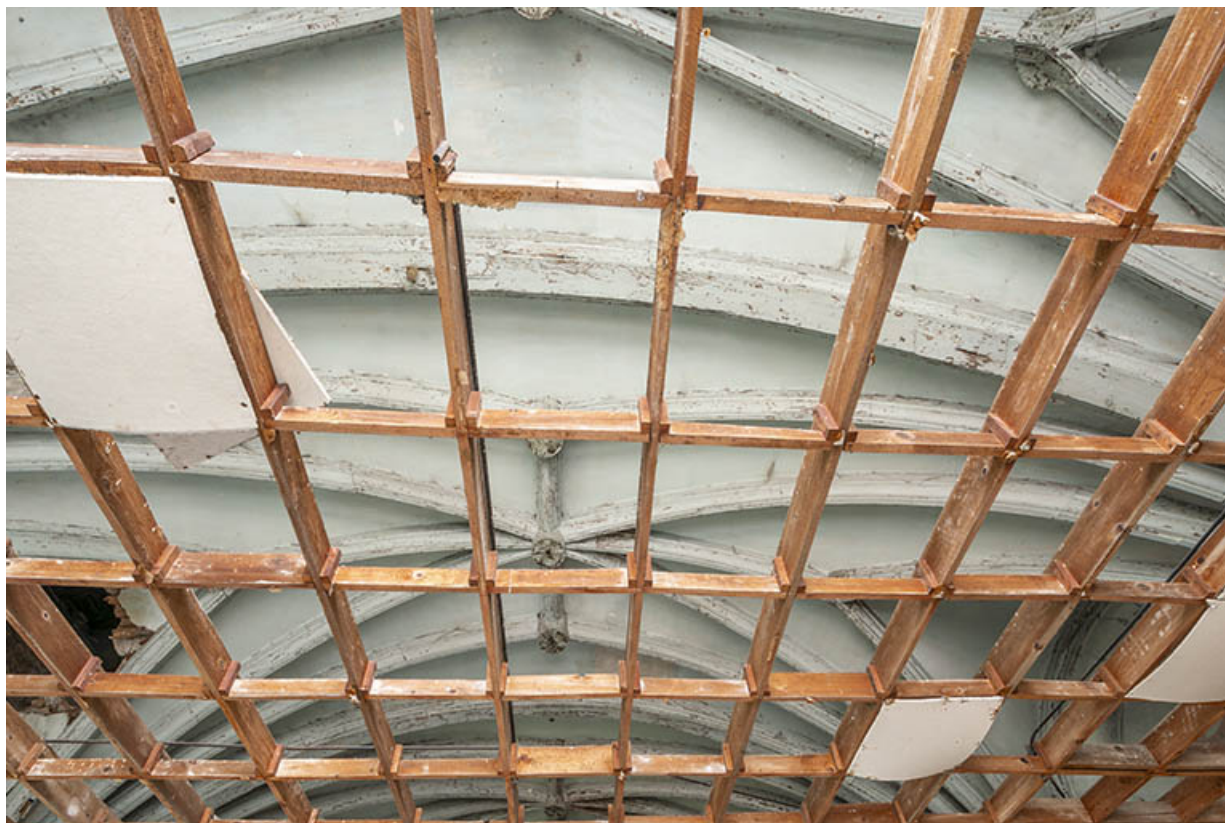
Ossature bois du plafond et voûtement de la nef.
