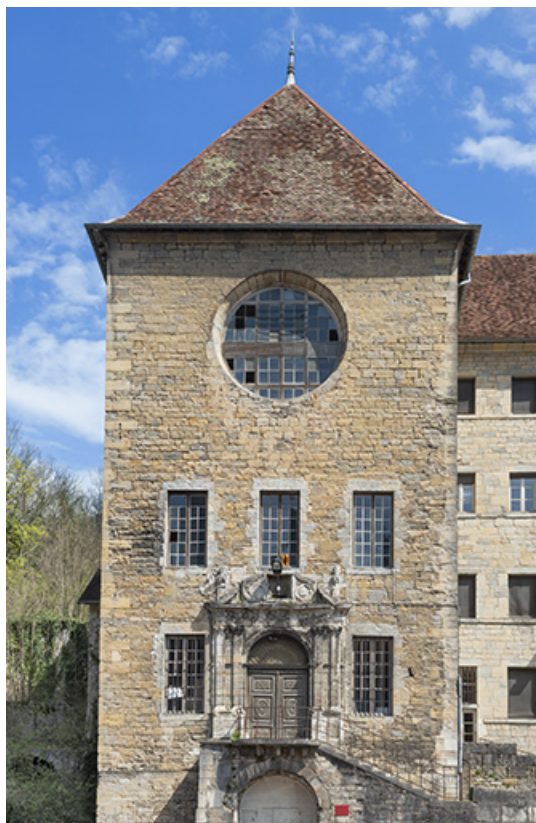
Façade ouest de la chapelle.
