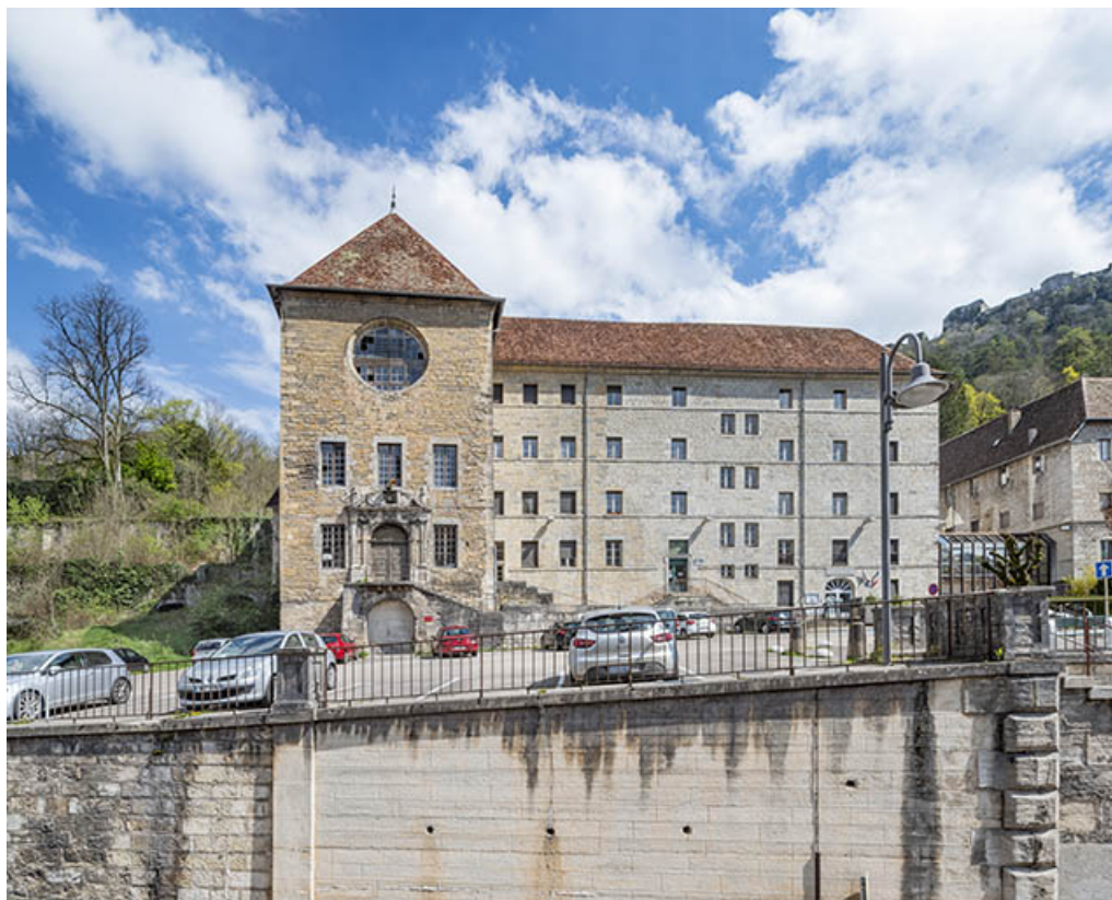
Vue d'ensemble depuis l'ouest.
