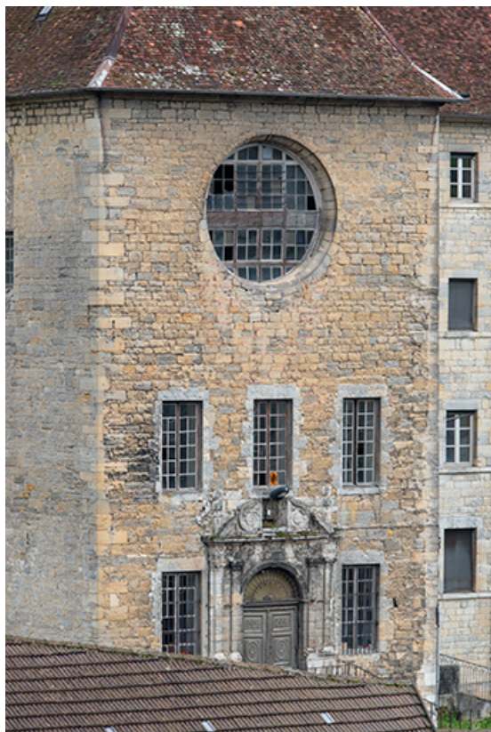
Façade ouest de la chapelle, depuis le nord-est. 39, Salins-les-Bains place Émile Zola
