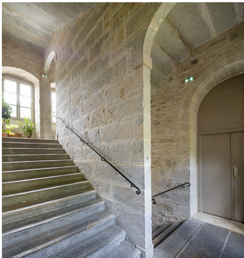
Aile ouest. Palier de l'escalier de distribution intérieure.
