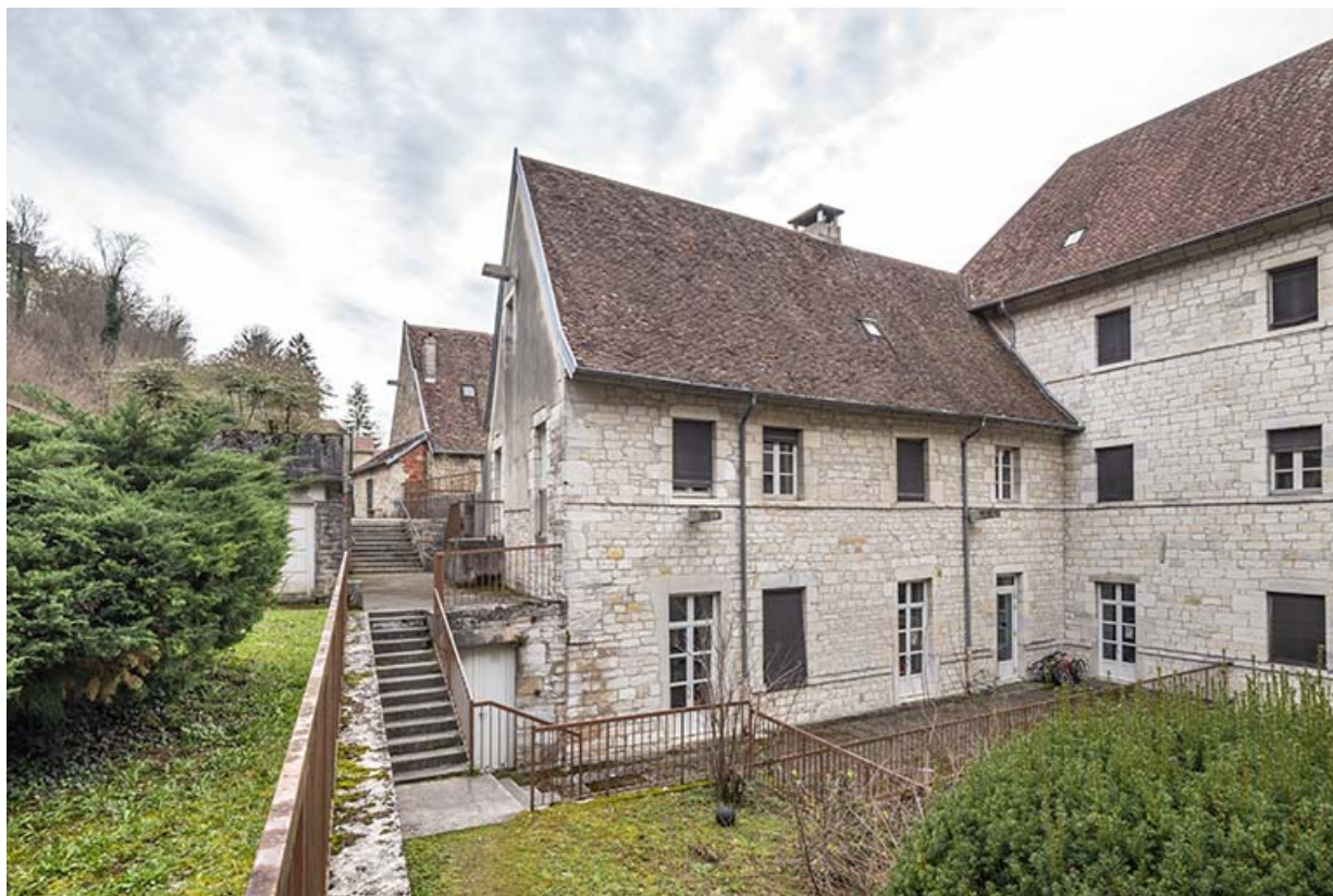
Façade sur cour de l'aile sud.
