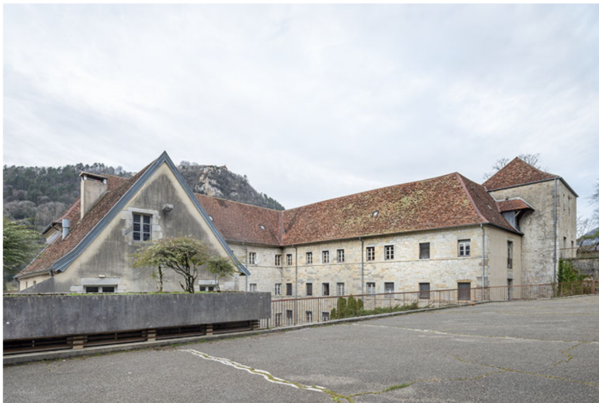
Vue rapprochée depuis le sud-est, au second niveau.
