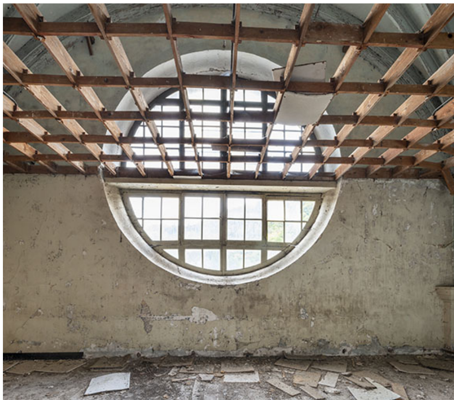
Vue intérieure de l'oculus (façade ouest), et ossature bois du plafond (salles de classe du collège). 39, Salins-les-Bains place Émile Zola
