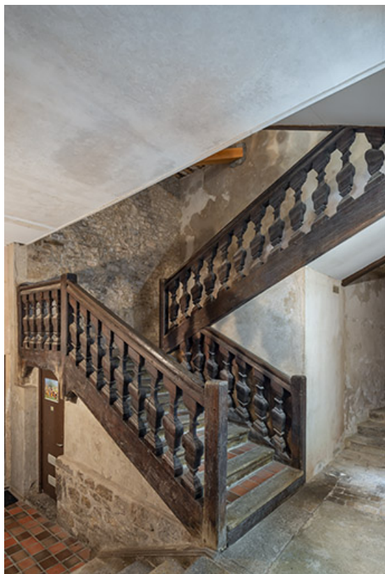
Extrémité orientale de l'aile nord. Escalier à balustres.
