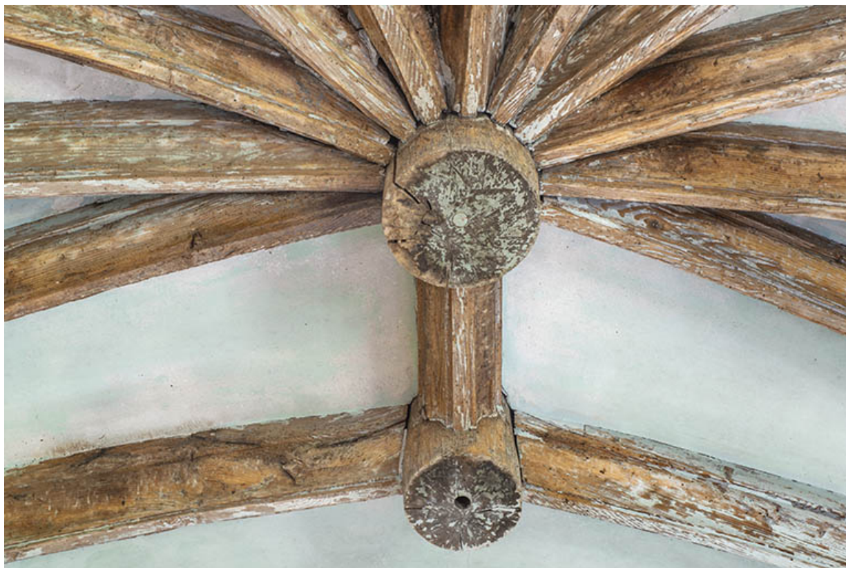
Chevet de la chapelle. Détail des clefs de voûte.
