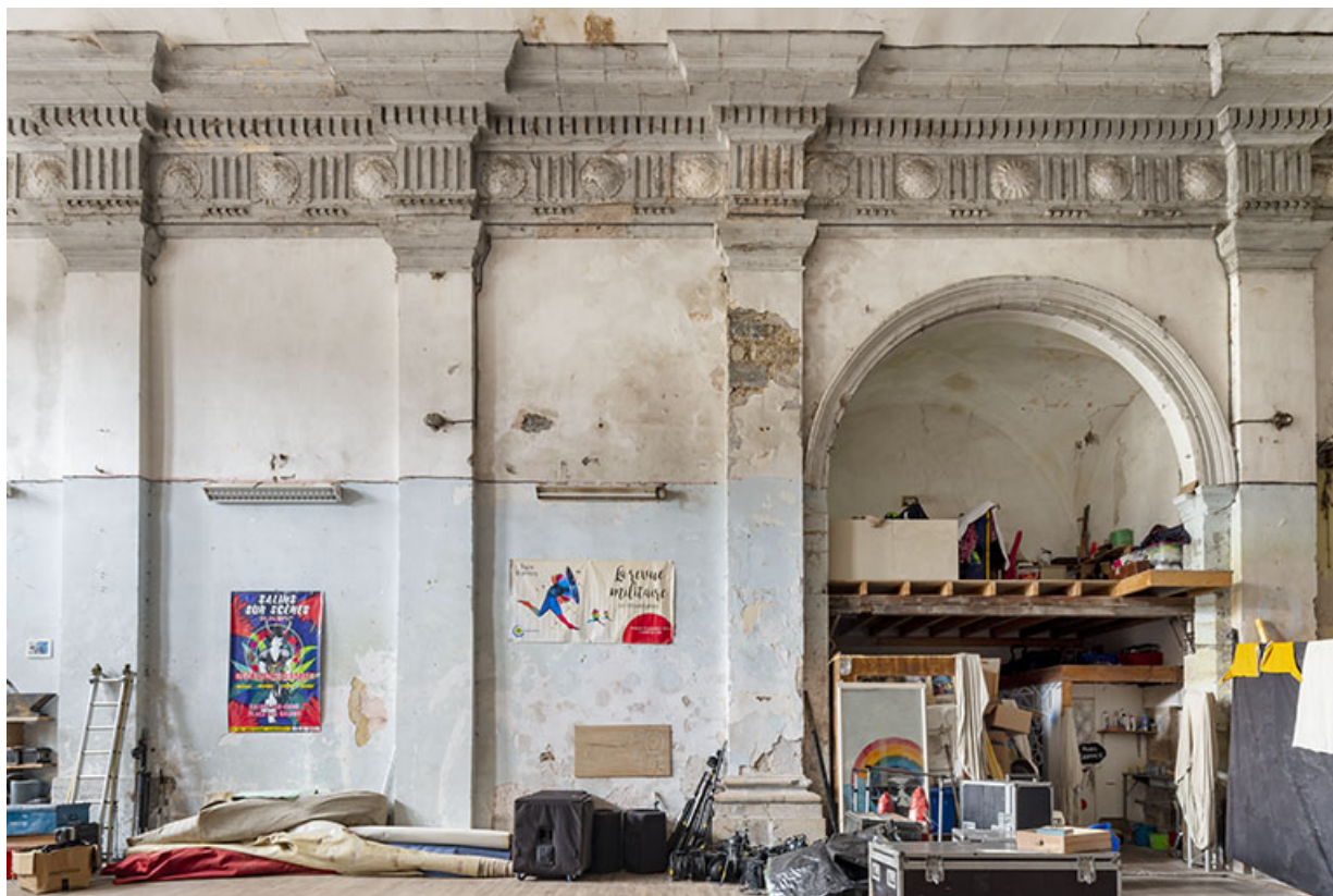
Élévation du mur nord de la chapelle.
