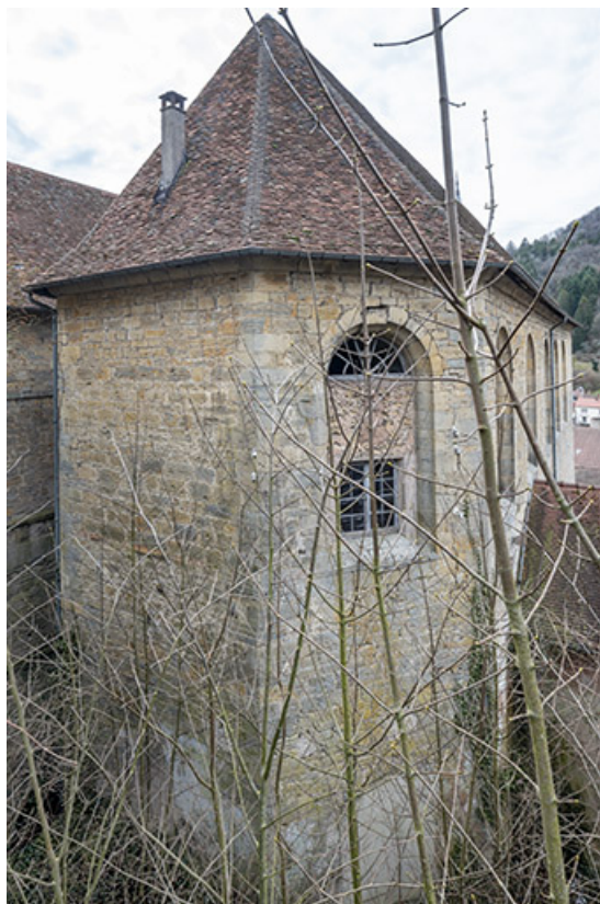
Chevet de la chapelle, depuis le nord.
