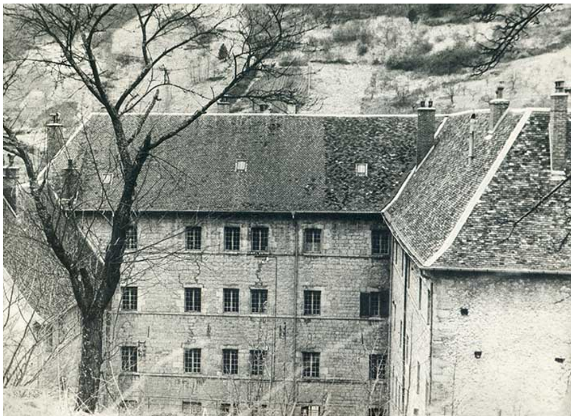
Façade sur la cour, vue de face, s.d. [milieu 20e siècle].
