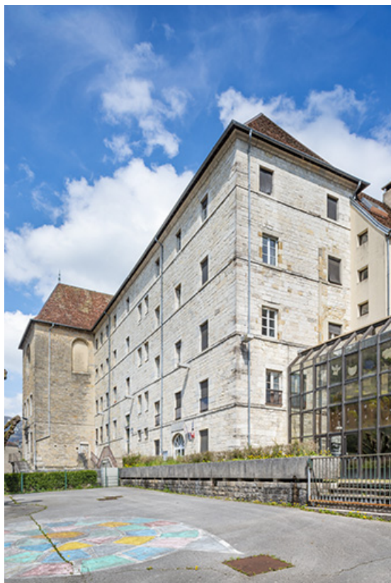
Façades antérieures vues de trois quarts droite.
