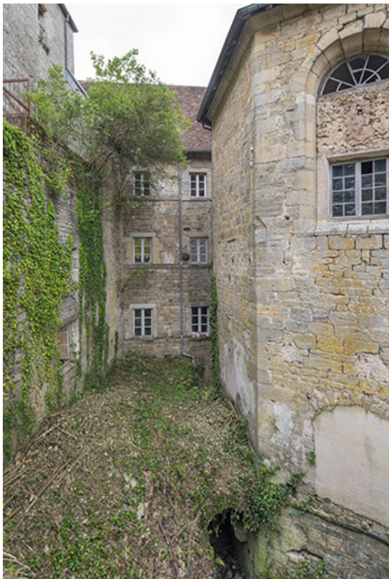
Passage entre le chevet de la chapelle et l'aile nord du collège.
