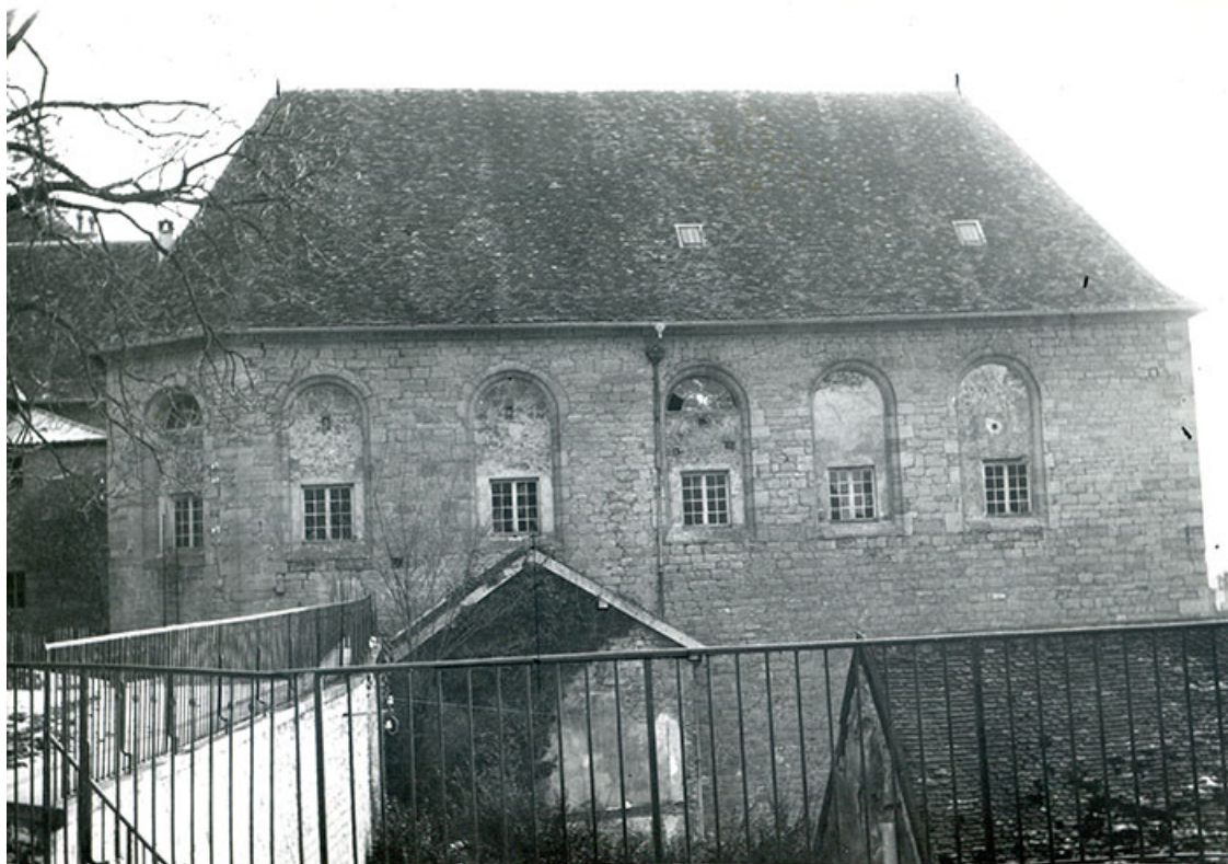
Façade nord de la chapelle, s.d. [milieu 20e siècle]. 39, Salins-les-Bains place Émile Zola
