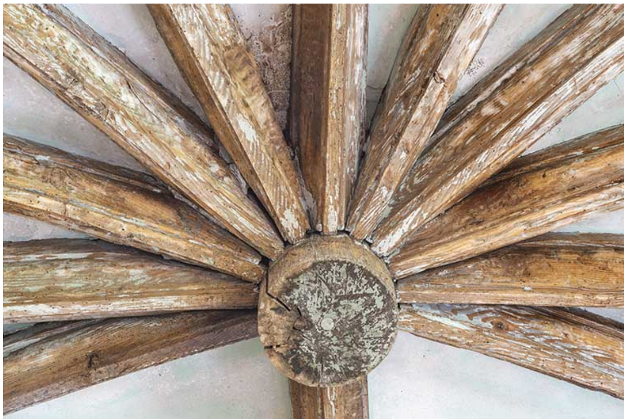
Chevet de la chapelle. Détail d'une clef et des départs des ogives.
