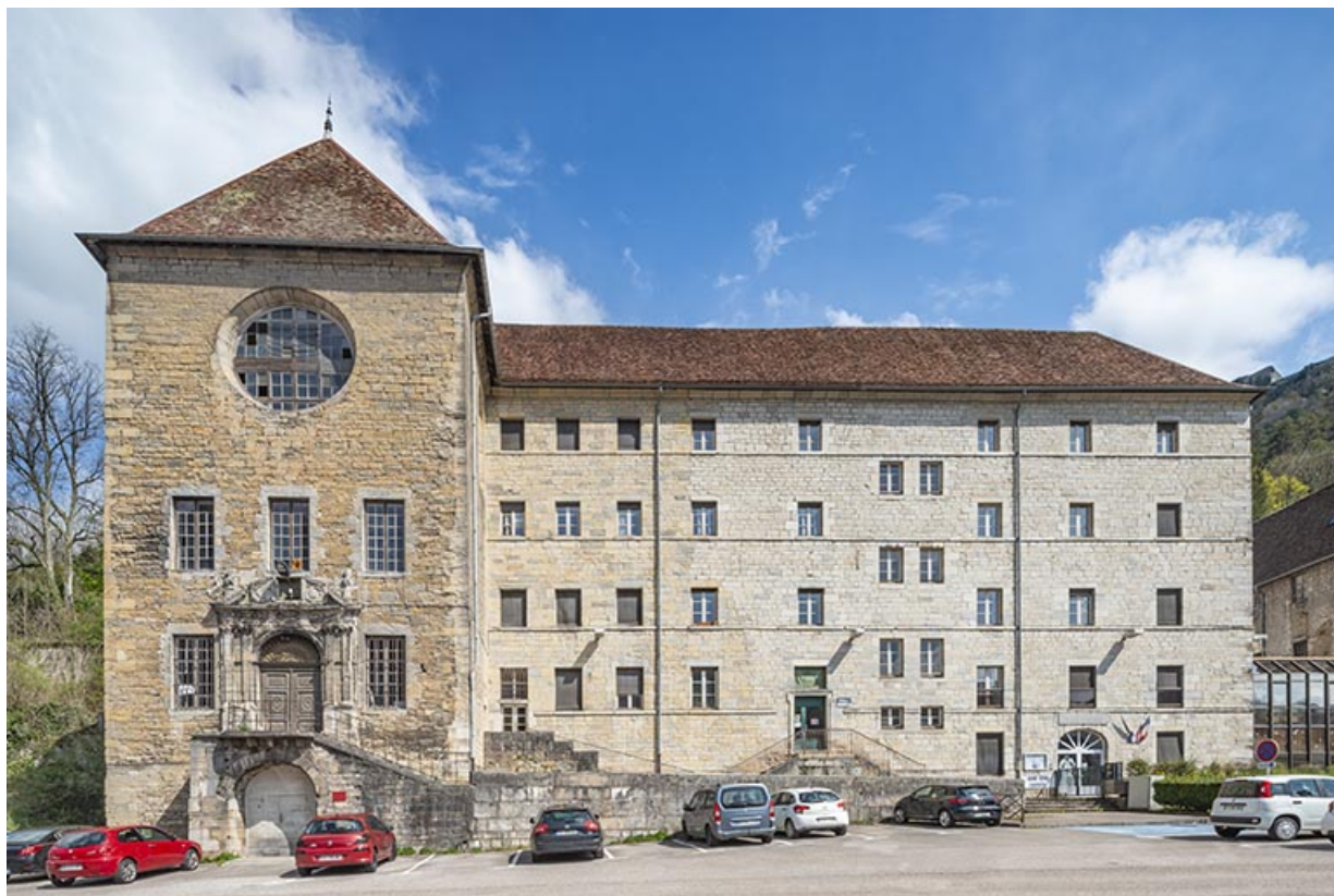
Vue rapprochée depuis l'ouest.
