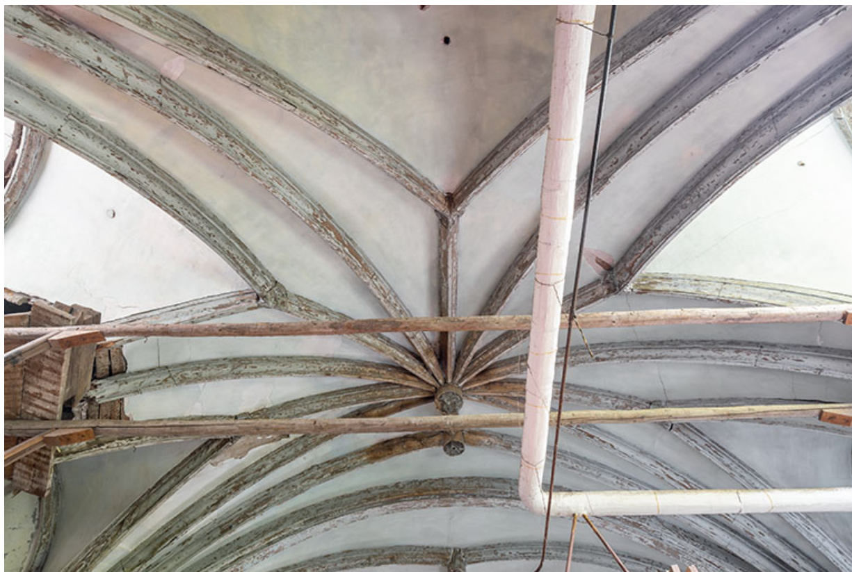
Voûtement du chevet de la chapelle (et pièces de charpente de consolidation). 39, Salins-les-Bains place Émile Zola
