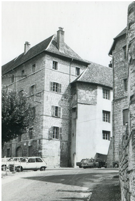
Angle sud-ouest du bâtiment, s.d. [3e quart du 20e siècle]. 39, Salins-les-Bains place Émile Zola
