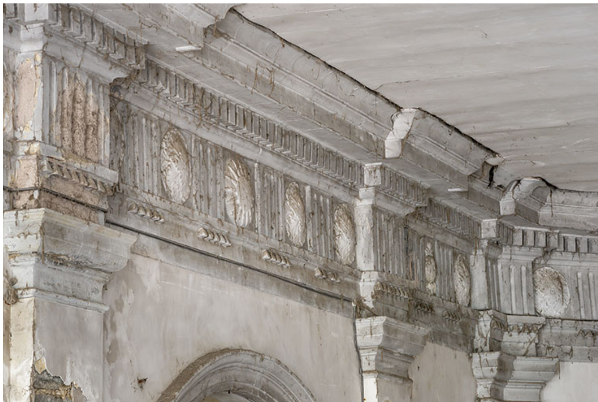
Mur nord de la chapelle. Détail de l'entablement.
