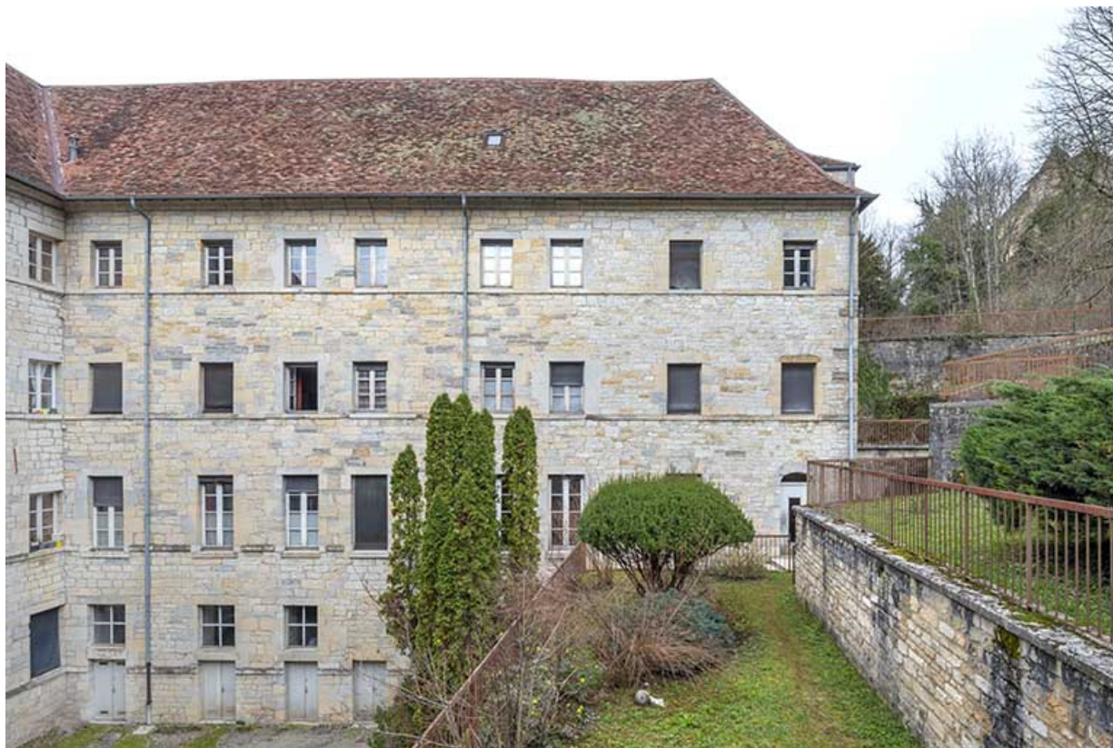
Façade sud de l'aile nord.
