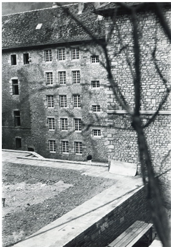
Façade sur la cour, vue de trois quarts, s.d. [milieu 20e siècle]. 39, Salins-les-Bains place Émile Zola
