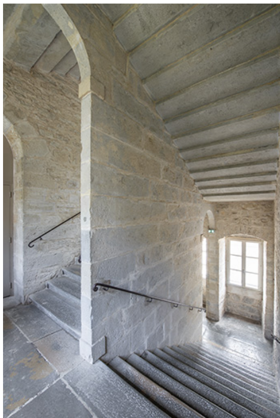
Aile ouest. Palier de l'escalier de distribution intérieure.
