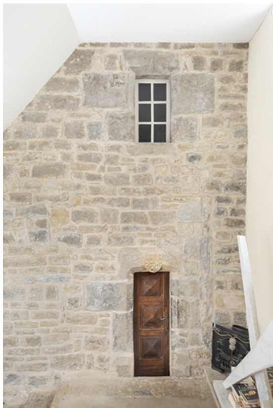
Intérieur du logis. Partie de mur médiéval.
