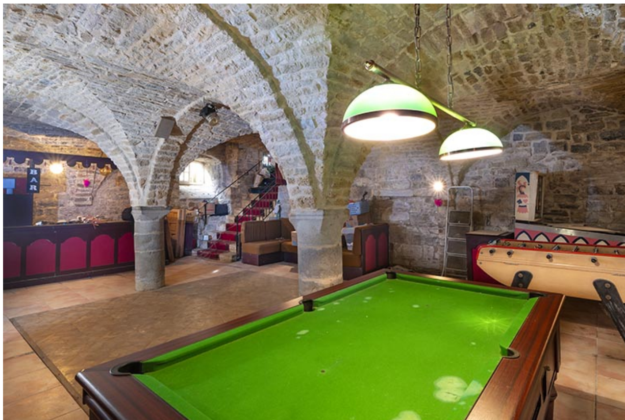
Cave voûtée d'arêtes, vue depuis le sud-ouest.
