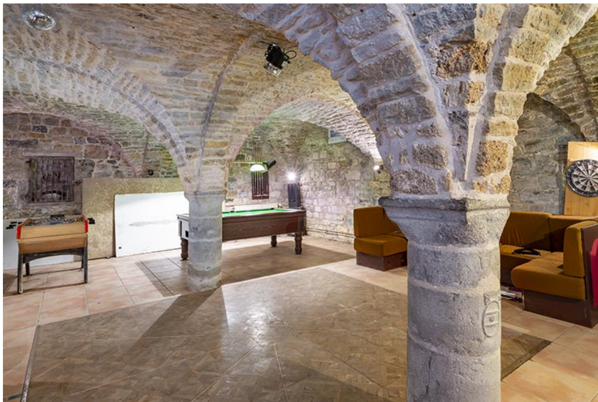
Cave voûtée d'arêtes, vue depuis le nord-est.
