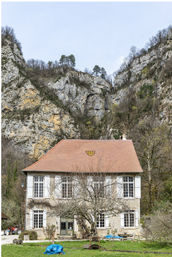
Façade sud du logis abbatial (cadrage vertical).
