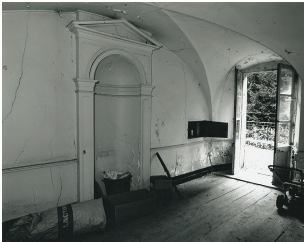
Rez-de-chaussée du bâtiment conventuel. Pièce à l'angle sud-ouest, 1997.
