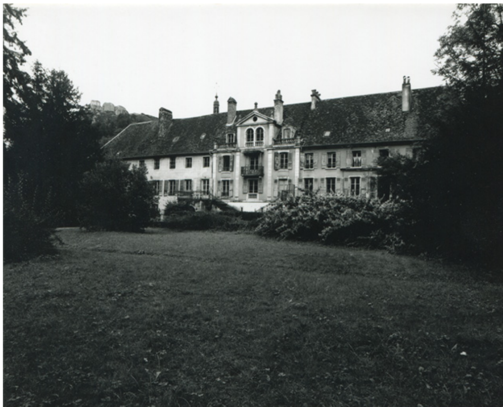
Vue d'ensemble de la façade sud du bâtiment conventuel, 1997.
