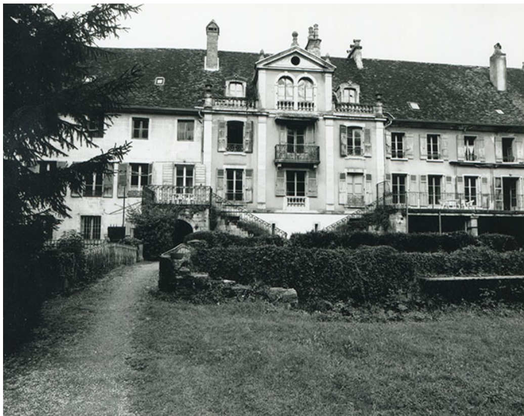
Façade sud du bâtiment conventuel, 1997. 39, Salins-les-Bains, 68-76 rue Louis Pasteur
