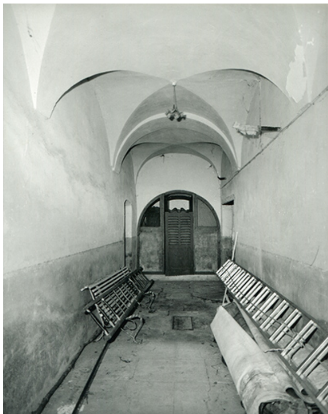
Rez-de-chaussée du bâtiment conventuel. Couloir transversal au niveau du grand escalier, 1997. 39, Salins-les-Bains, 68-76 rue Louis Pasteur
