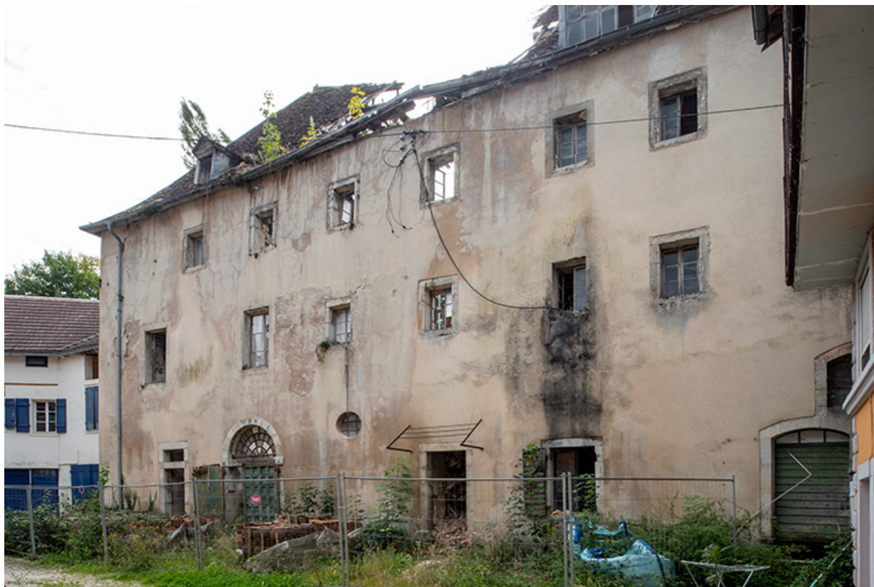
Façade nord du grand bâtiment conventuel.
