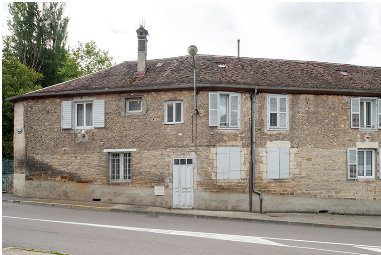
Extrémité est des bâtiments conventuels. Façade nord.
