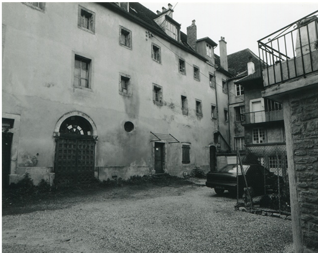
Façade nord du bâtiment conventuel, 1997. 39, Salins-les-Bains, 68-76 rue Louis Pasteur
