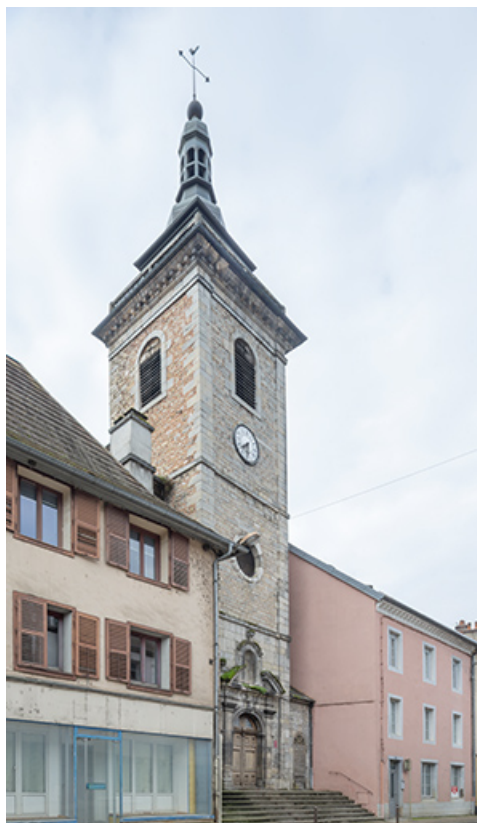
Façade nord de l'église de trois quarts gauche.
