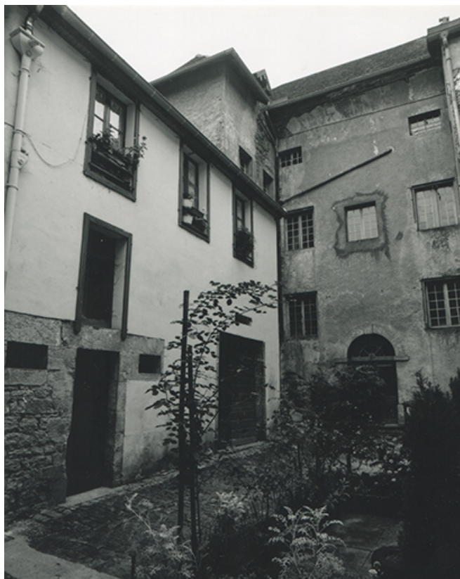
Bâtiment est du cloître et bâtiment conventuel principal, 1997.
