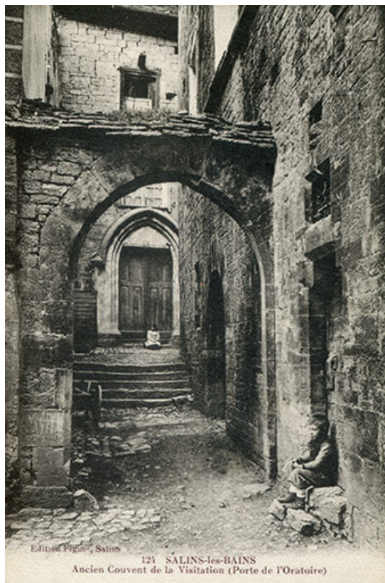
Salins-les-Bains - Ancien couvent de la Visitation (Porte de l'Oratoire), s.d. [fin 19e ou début 20e siècle]. 39, Salins-les-Bains, 5, 7 rue du Temple
