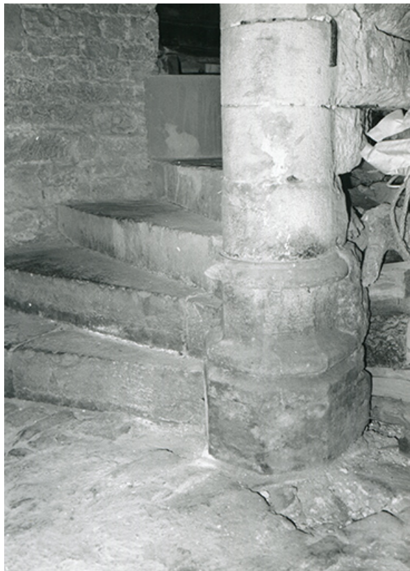
Logis. Base de l'escalier en vis, 1990. 39, Salins-les-Bains, 5, 7 rue du Temple
