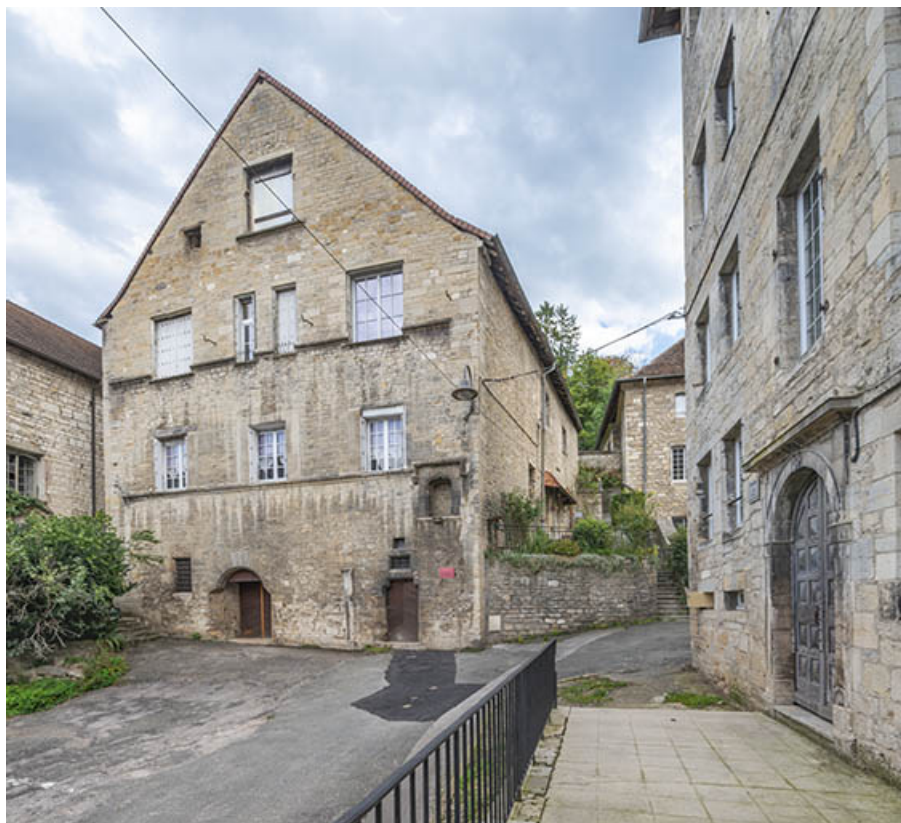
Façade ouest vue de trois quarts droite.
