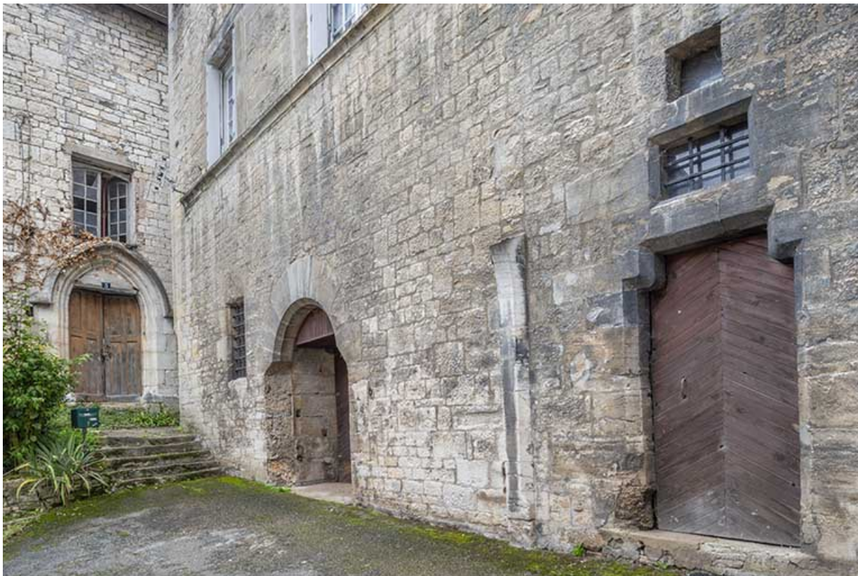
Porte de la chapelle et rez-de-chaussée de la façade ouest.
