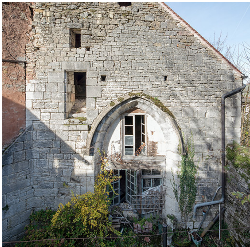
Élévation du mur de chevet. Vue de face.
