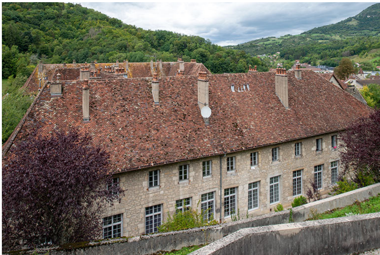
Façade est du bâtiment amont.
