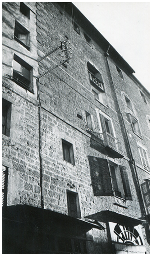
Travées nord de la façade ouest, s.d. [vers 1950]. 39, Salins-les-Bains, 9 rue du Temple
