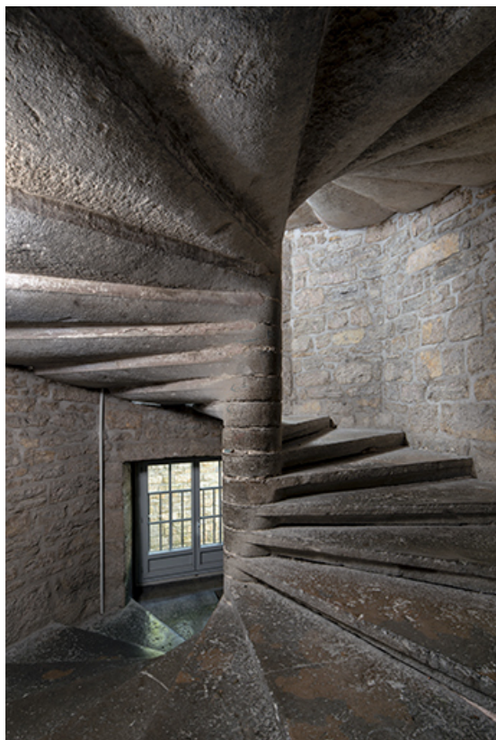
Escalier sud du bâtiment amont. Vue depuis le premier palier.
