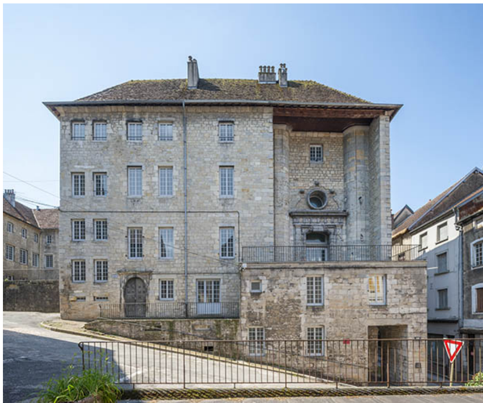
Façade nord du bâtiment sur rue.
