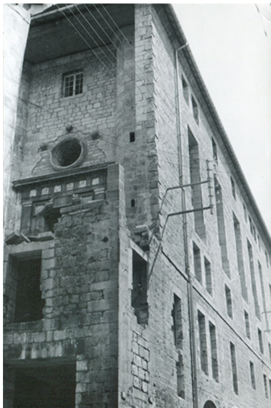
Bâtiment sur rue en cours de réhabilitation, s.d. [vers 1955].
