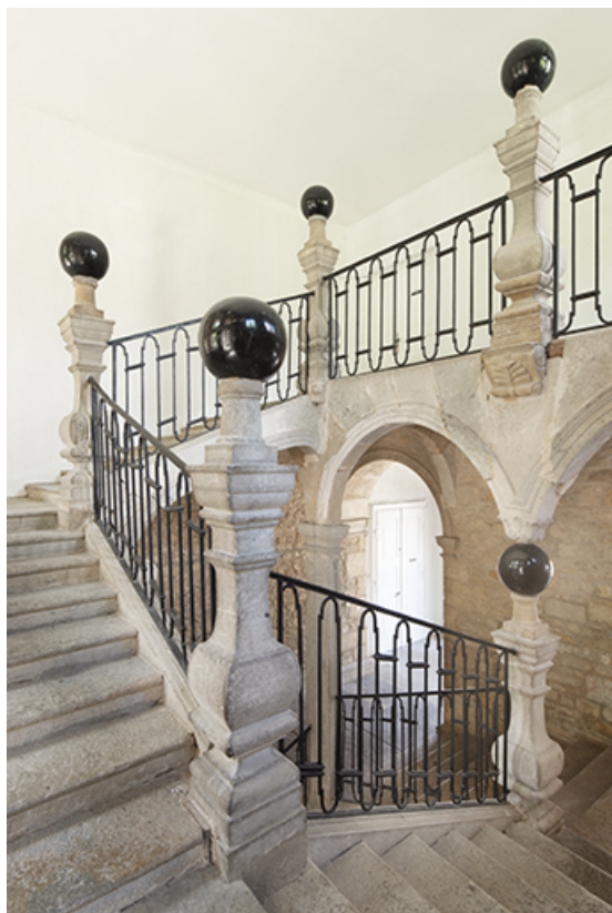
Escalier dit "aux boules de pierre". Rampe en ferronnerie et balustres entre le premier et le second étage. 39, Salins-les-Bains, 9 rue du Temple
