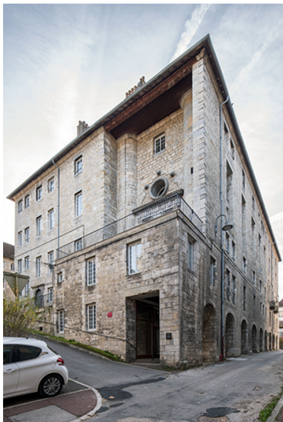
Vue detrois quarts du bâtiment sur rue (ancienne chapelle).
