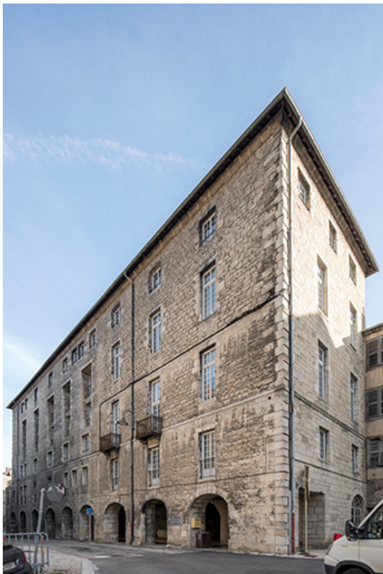
Élévation sur rue depuis le sud-ouest.
