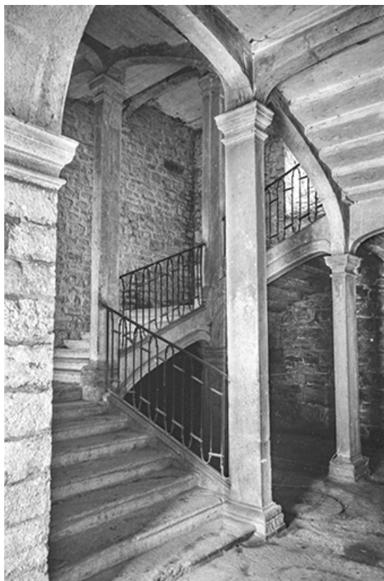
Grand escalier, s.d. [vers 1960].
