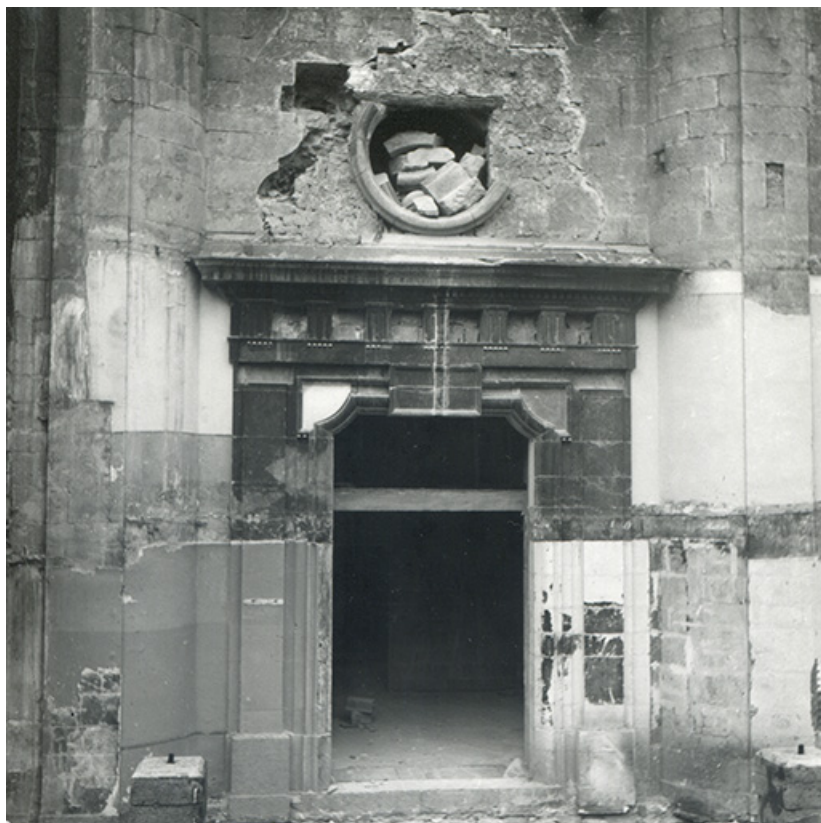
Porte de la chapelle avant restauration, s.d. [vers 1955].
