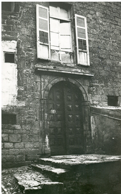
Porte du bâtiment sur rue (façade nord), s.d. [vers 1955]. 39, Salins-les-Bains, 9 rue du Temple
