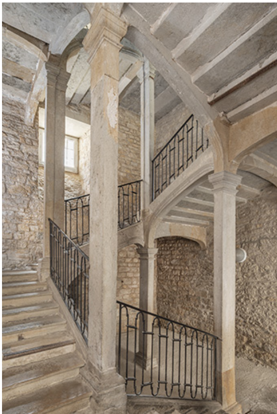
Escalier dit "aux boules de pierre". Vue depuis le premier palier.
