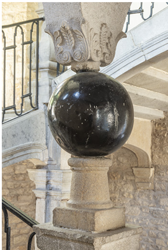
Premier étage de l'escalier dit "aux boules de pierre". Détail de la retombée d'un arc sur la sphère noire. 39, Salins-les-Bains, 9 rue du Temple
