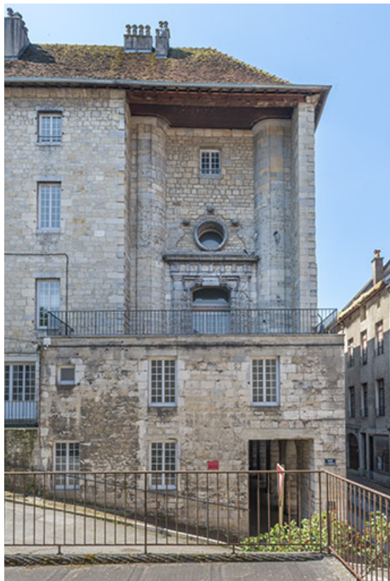
Élévation nord. Entrée de la chapelle.
