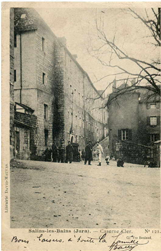
Salins-les-Bains (Jura) - Caserne Cler, s.d. [début 20e siècle]. 39, Salins-les-Bains, 9 rue des Claristes
