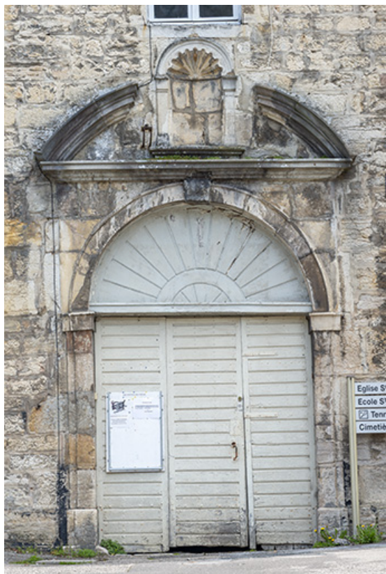
Porte principale du bâtiment sur rue. Vue de face.
