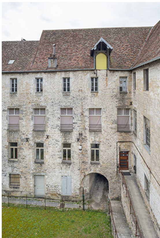
Travées nord de la façade sur cour, depuis la terrasse est.
