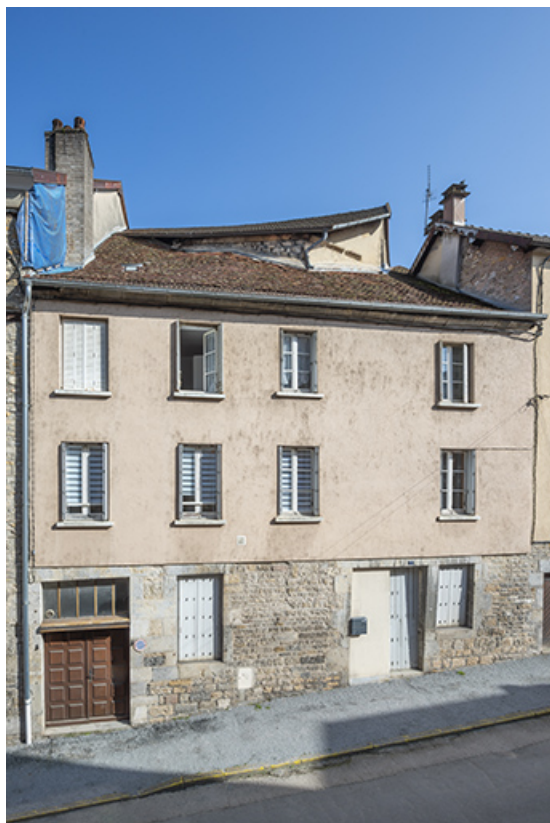
Façade ouest (rue Charles David).
