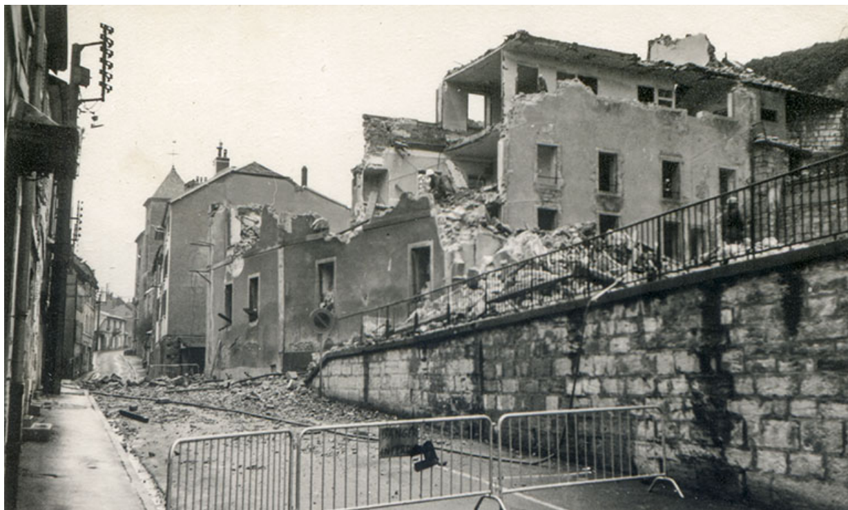
Démolition des bâtiments, vers 1973.
