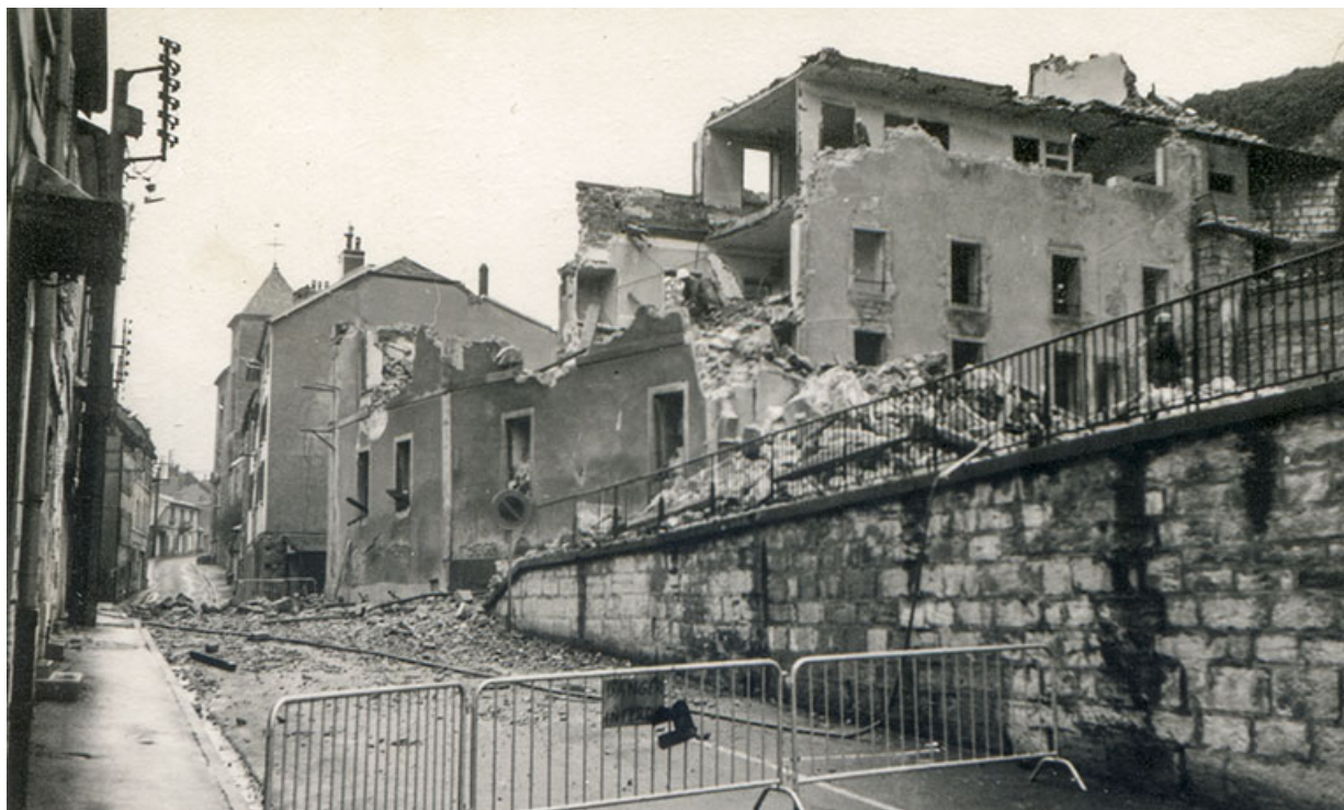
Démolition des bâtiments, vers 1973.
