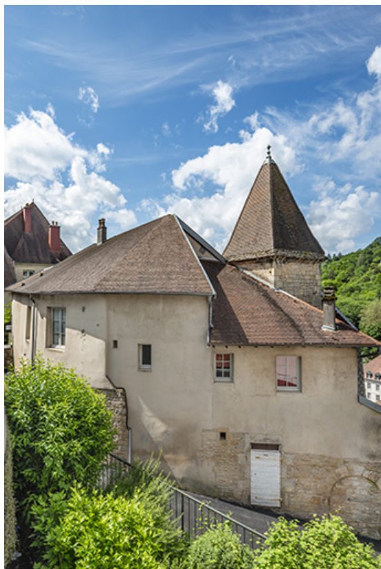
Vue plongeante depuis le nord-est.
