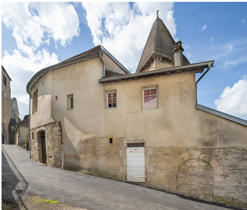
Façade nord, depuis la ruelle d'Arçon.
