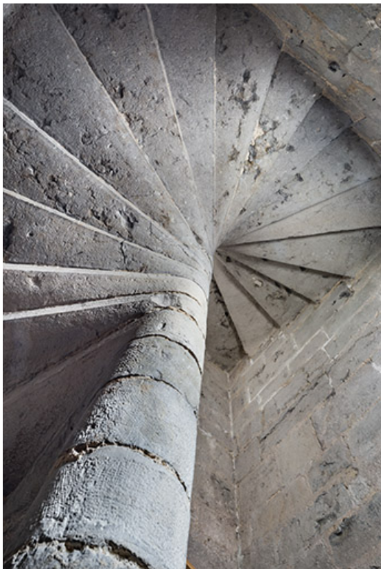
Escalier en vis. Vue en contre-plongée.
