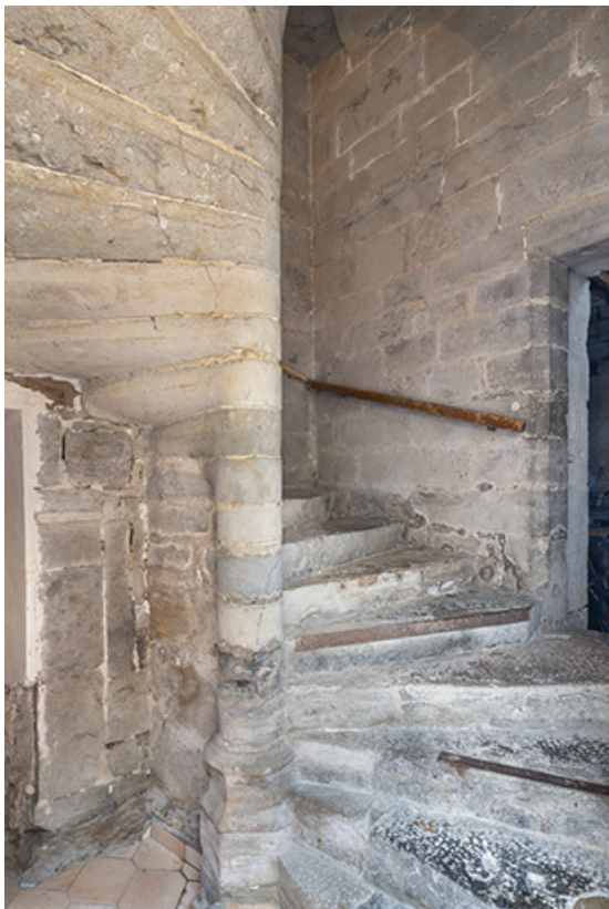
Escalier en vis (bâtiment sur rue).
