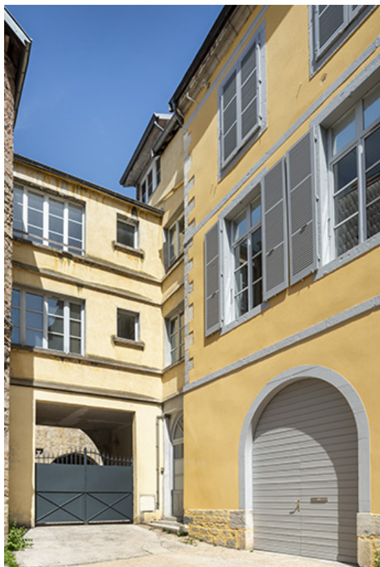
Vue de l'angle nord-est des bâtiments depuis la cour.
