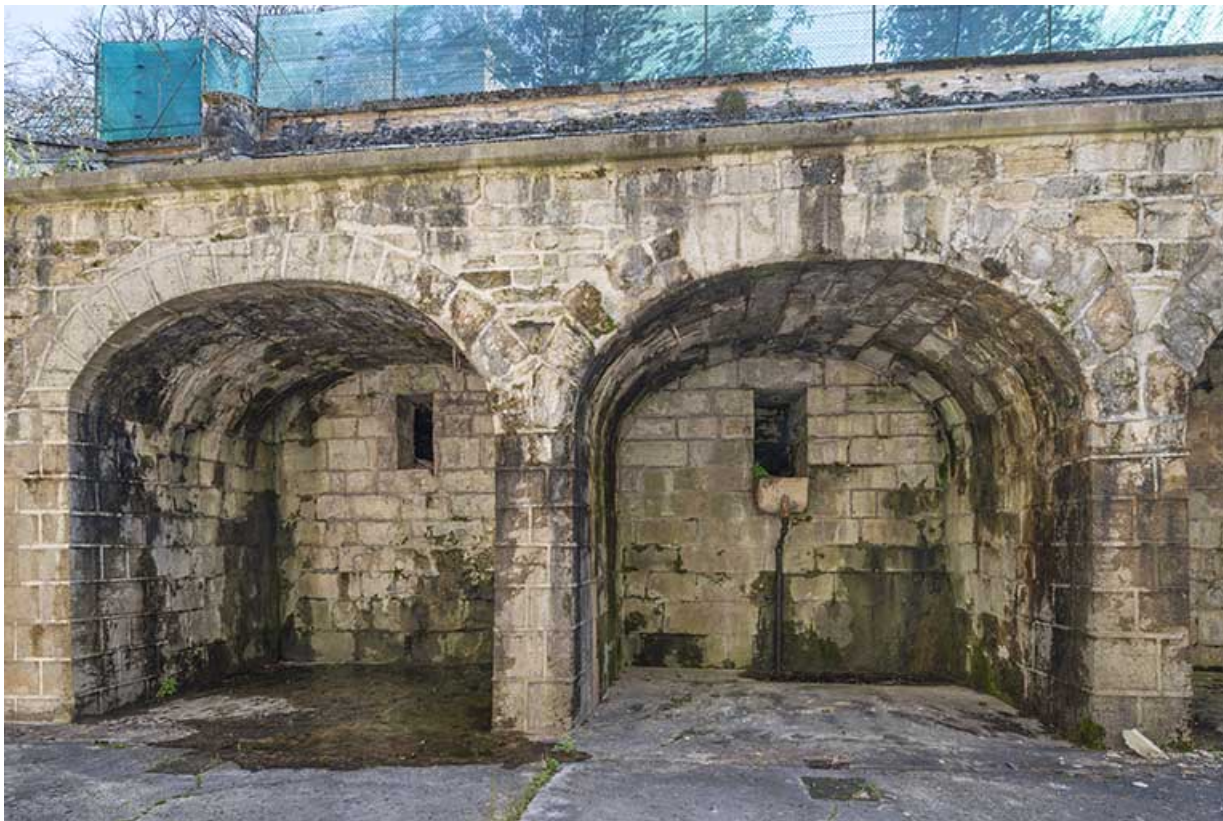
Cour ouest. Construction maçonnée voûtée en berceau en arc segmentaire, formant terrasse.
